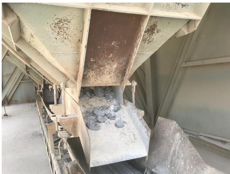
Figura 2 -Sistema de abastecimento em funcionamento atualmente na empresa estudada
