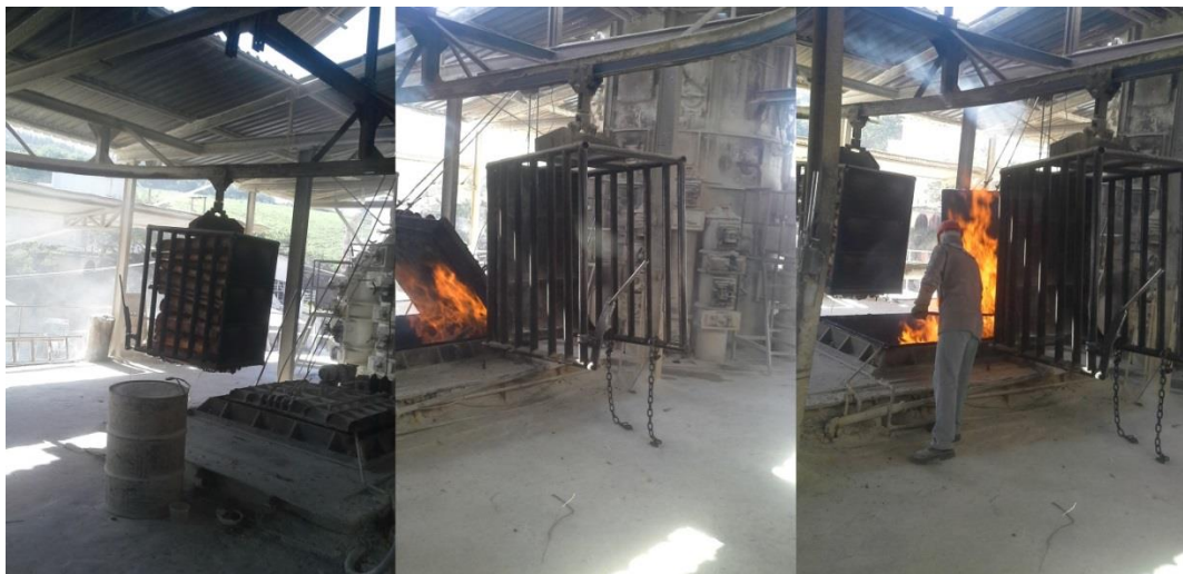
Figura 7 - Suporte para abastecimento de combustível em forno de calcinação
