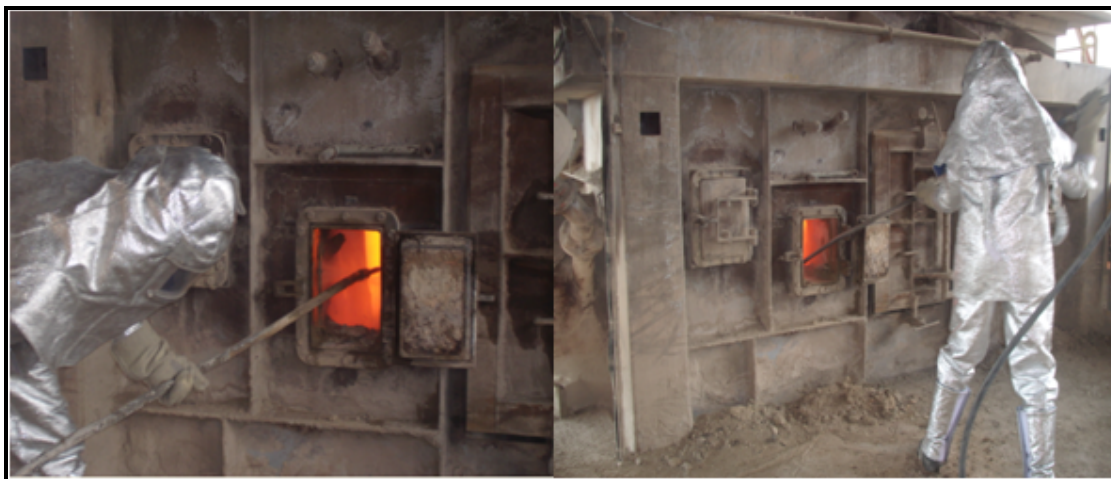
FIGURA 40 – Colaborador executando limpeza na caixa de fumaça com bomba hidráulica de alta pressão.
