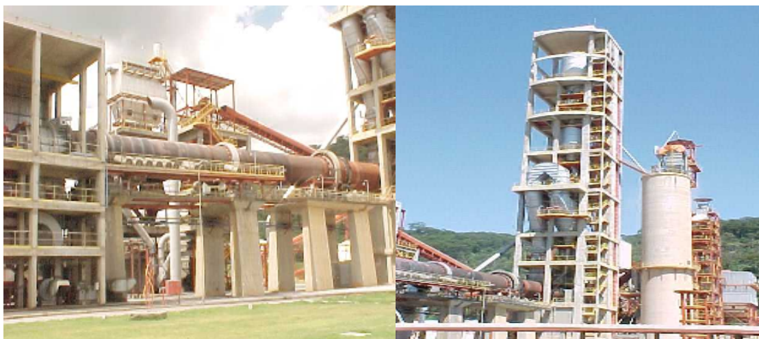
FIGURA 6 – Forno rotativo via seco para produção de clínquer.
