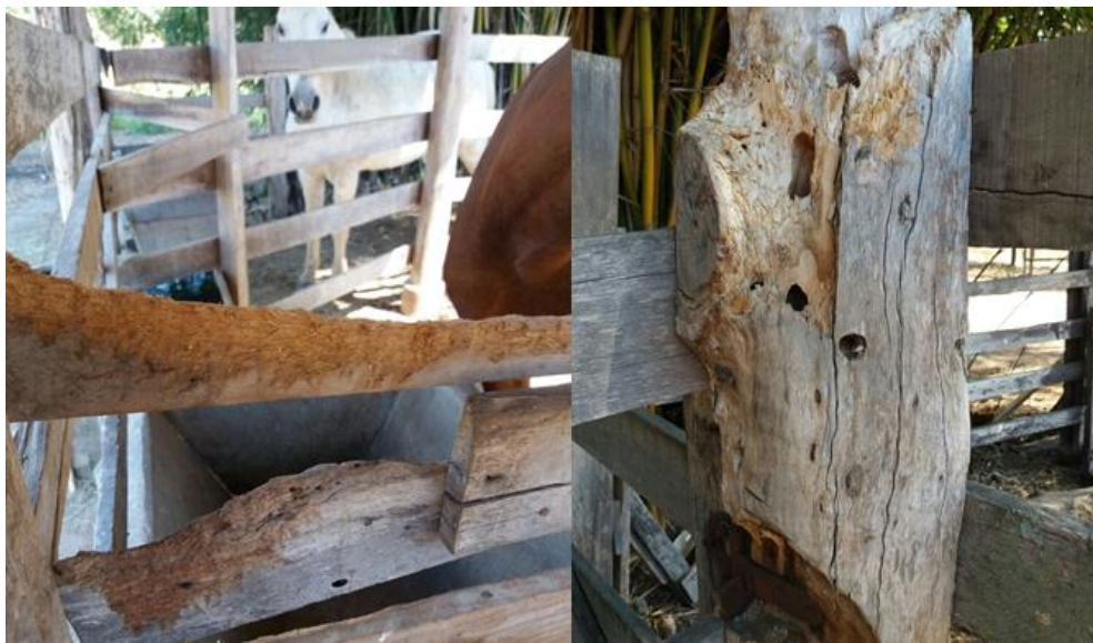
Figura 4 - Régua e poste da baia mordidos.
