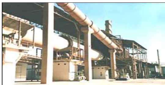
Figura 16 – Vista externa de um forno de clínquer Fonte: VOTORANTIM CIMENTOS, 2000.
