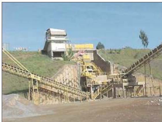
Figura 3 – Vista de uma instalação de britagem Fonte: VOTORANTIM CIMENTOS, 2000
