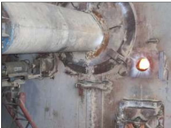
Figura 31: injeção de combustível no forno Fonte: Lafarge – Arcos 2009
