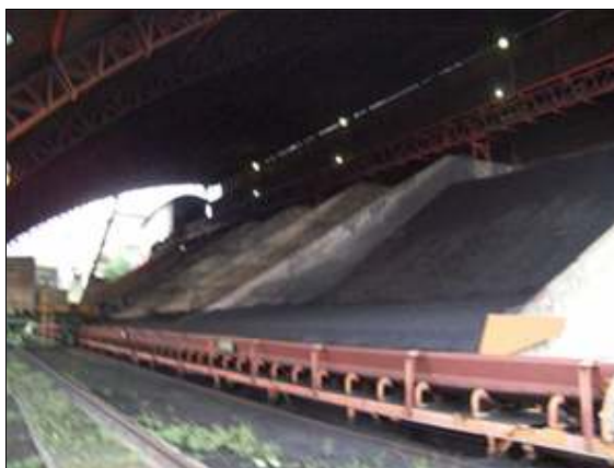
Figura 27: Baias de estocagem de combustíveis e blend Fonte: Lafarge - Arcos 2009
