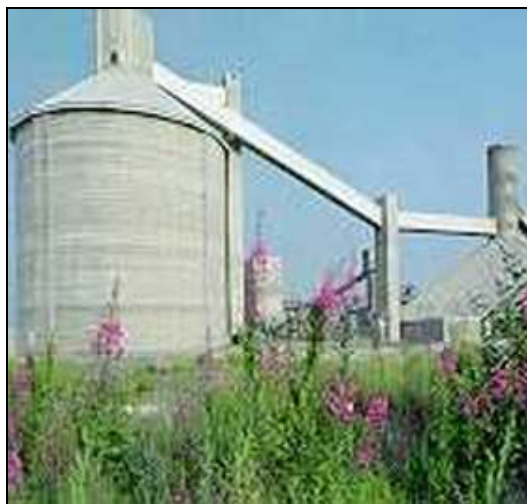
Figura 19 – Silo de armazenamento de clínquer Fonte: VOTORANTIM CIMENTOS, 2000.
