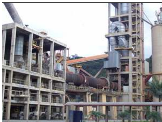
Figura 32: injeção de combustível na torre Fonte: Lafarge – Arcos 2009
