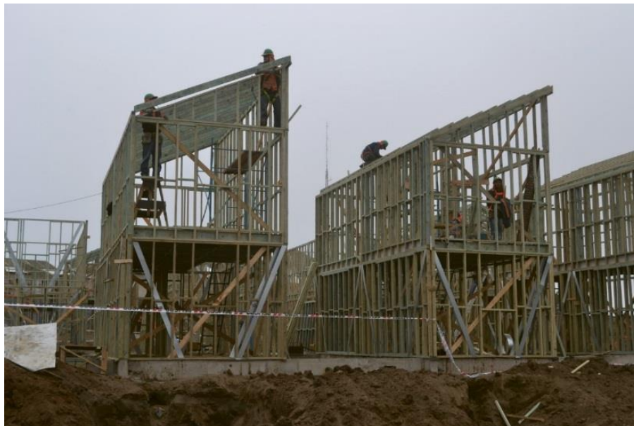
Figura 36 – Construção da estrutura da habitação Villa Verde
