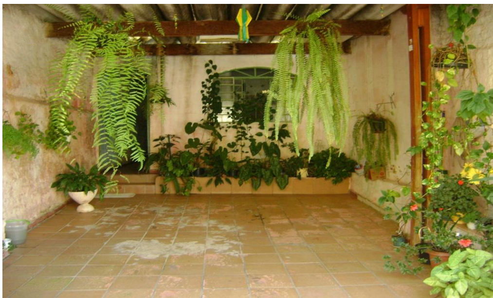
Figura 17 – Fachada antes da demolição.
