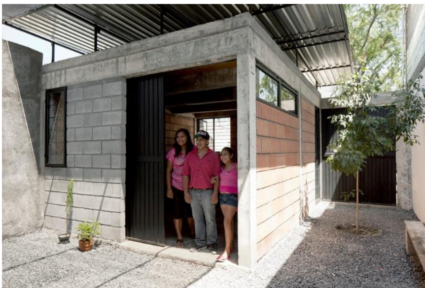
Figura 64 – Área Externa Casa Coberta.
