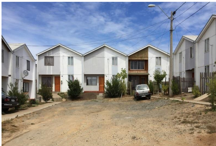
Figura 49 – Alterações das fachadas e ampliação da residência – Habitação Vila Verde
