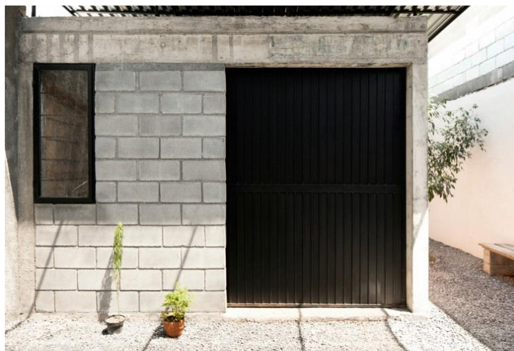
Figura 62 – Entrada da Cozinha, Sala de Estar e Jantar.
