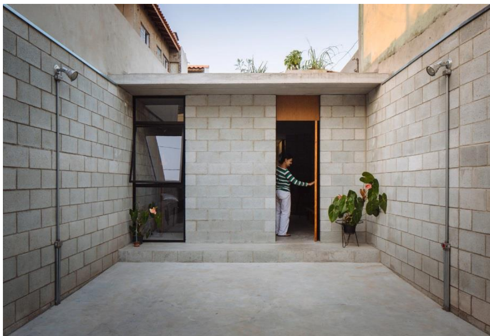
Figura 18 – Fachada depois da demolição.
