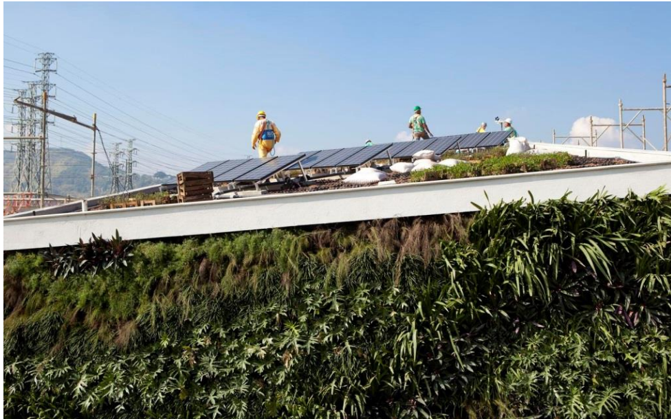
Figura 4 - Aplicação das placas fotovoltaicas no telhado
