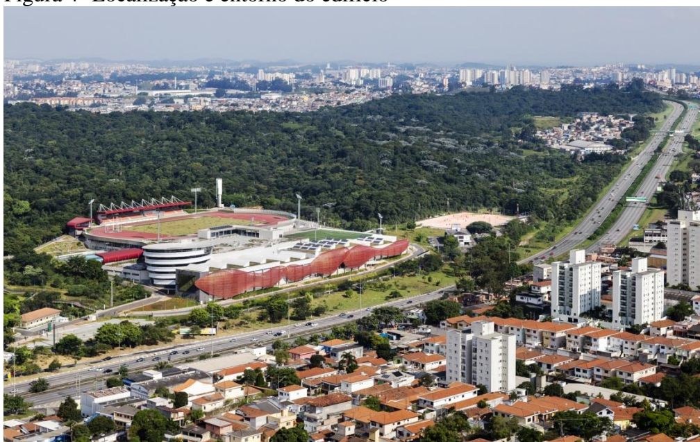
Figura 4- Localização e entorno do edifício
