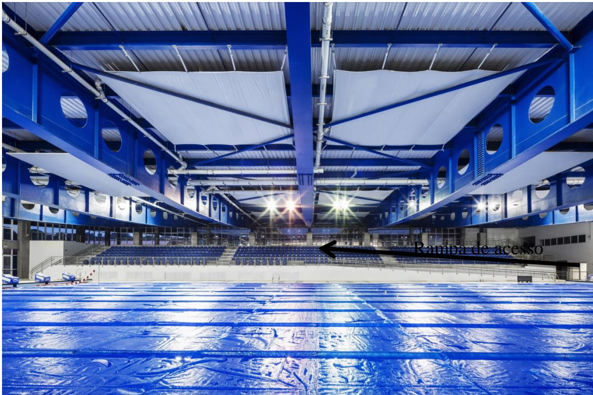
Figura 5- Área da piscina com destaque na acessibilidade
