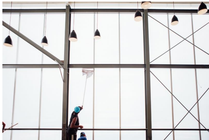
Figura 4 – Material utilizado para fechamento da edificação
