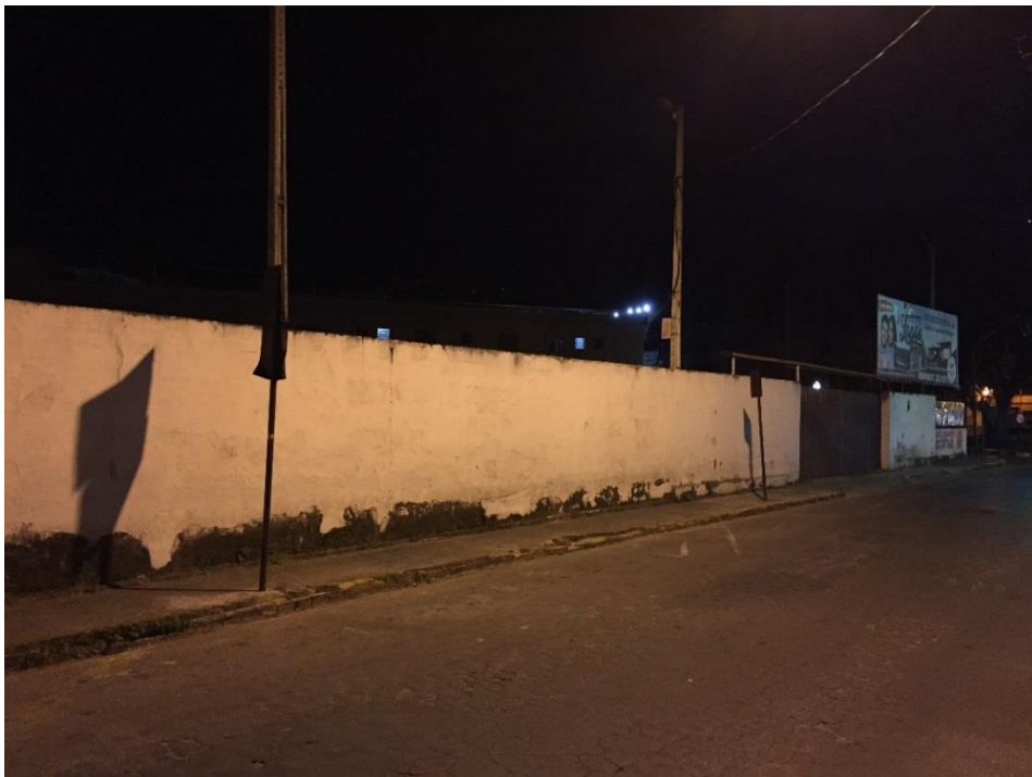
Figura 49 – Vista principal do terreno com acesso pela rua General Carneiro
