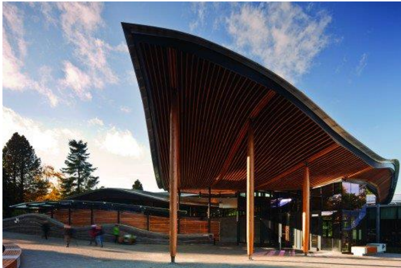
Figura 46 - Estrutura em madeira da cobertura
