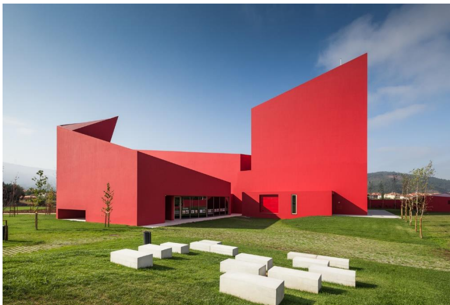
Figura 27 - Planos inclinados da cobertura
