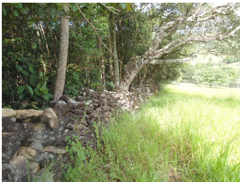
Figura 53 - Muro de pedra e faixa de reserva
