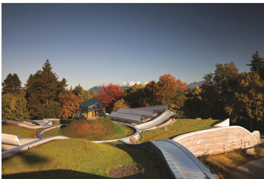
Figura 42 - Vista do telhado verde
