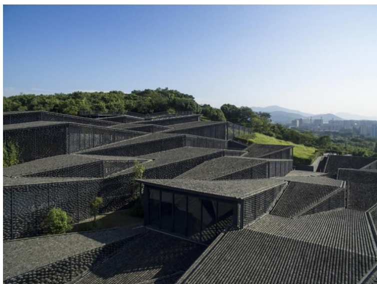
Figura 35 - Relação edifício e encosta
