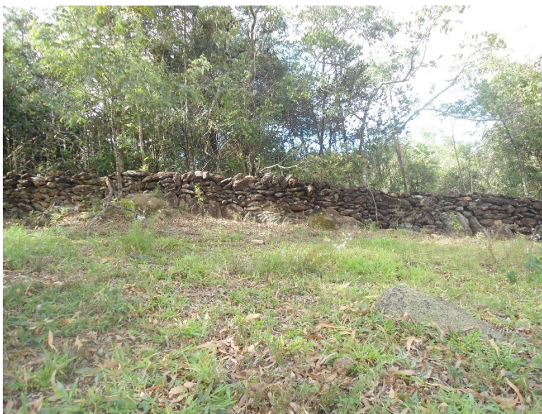
Figura 15 - Vista Frontal de parte do muro de pedras
