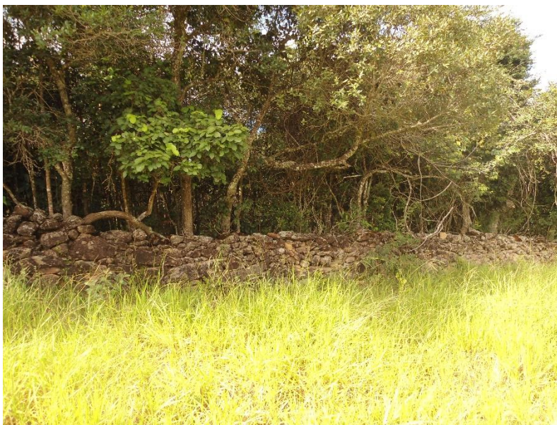
Figura 16 - Vista Frontal de parte do muro de pedras
