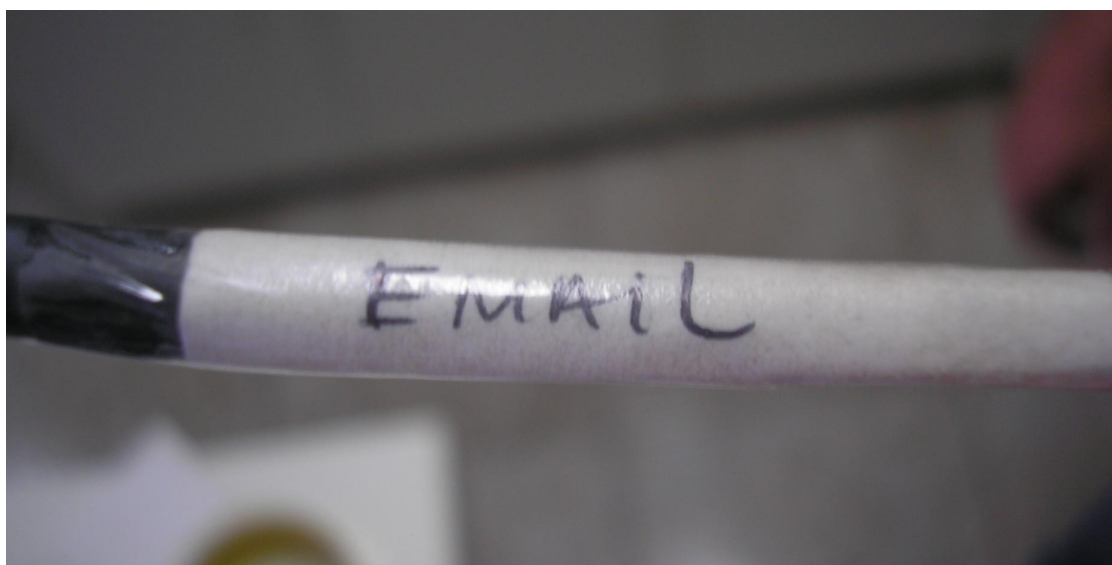
FIGURA 17 – Cabos identificados.
