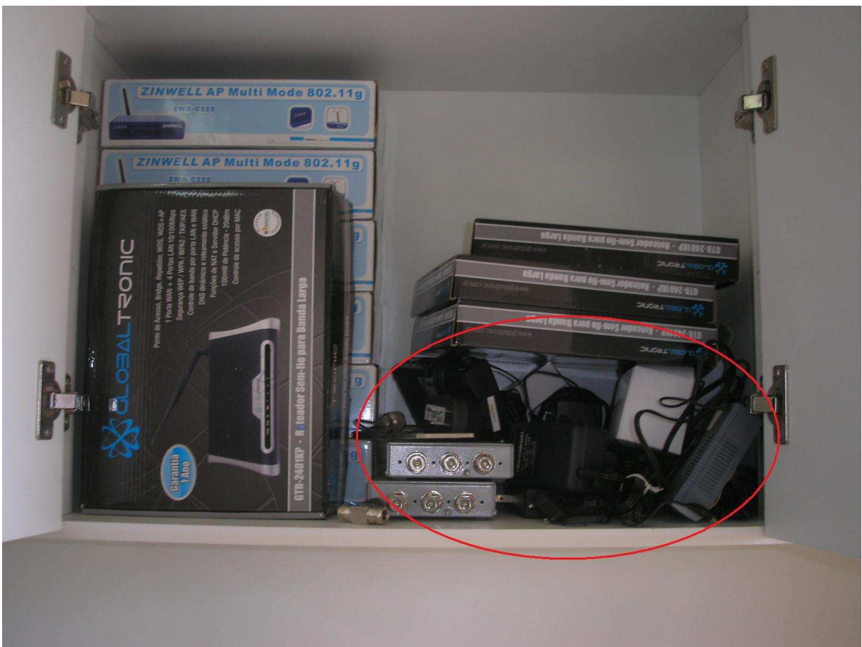
FIGURA 10 – Equipamentos usados armazenados junto aos novos.
