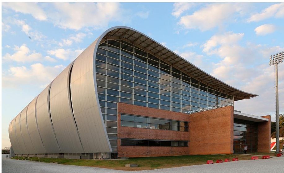
Figura 28 - Centro de Treinamento Esportivo da UFMG – CTE – Vista Lateral com Enfoque nas Frestas da Estrutura
