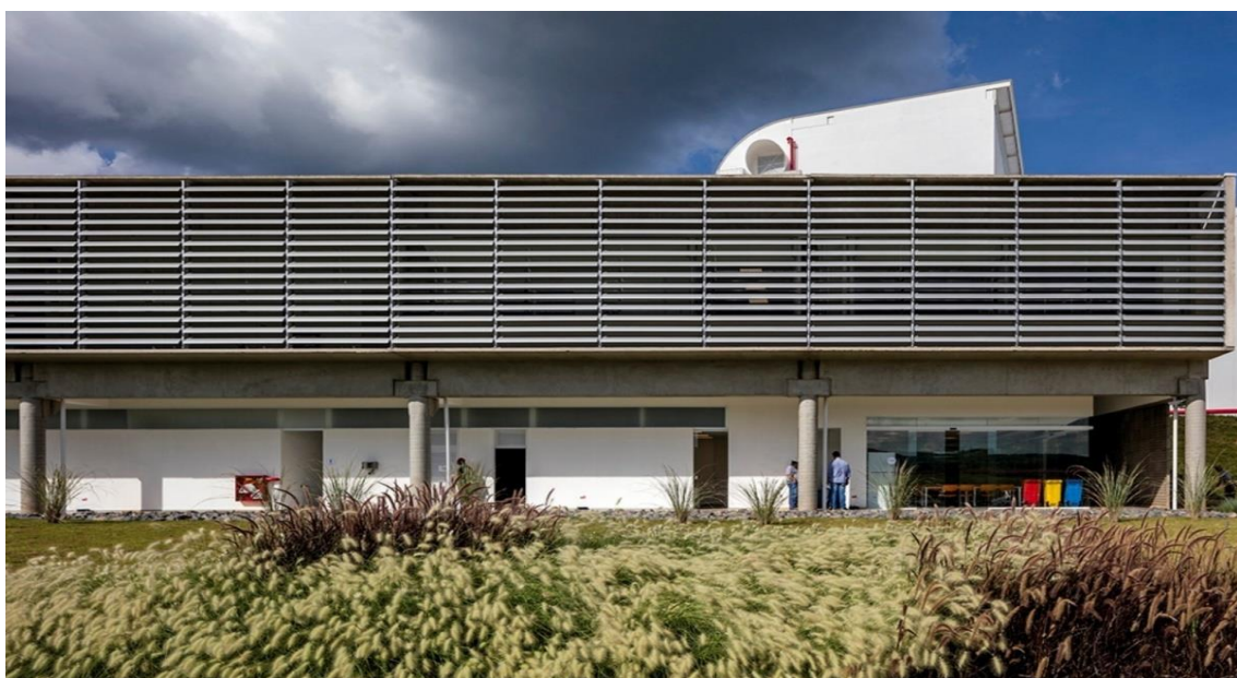
Figura 12 – Danone Early Life Nutrition: pilares e vigas de concreto pré-moldado
