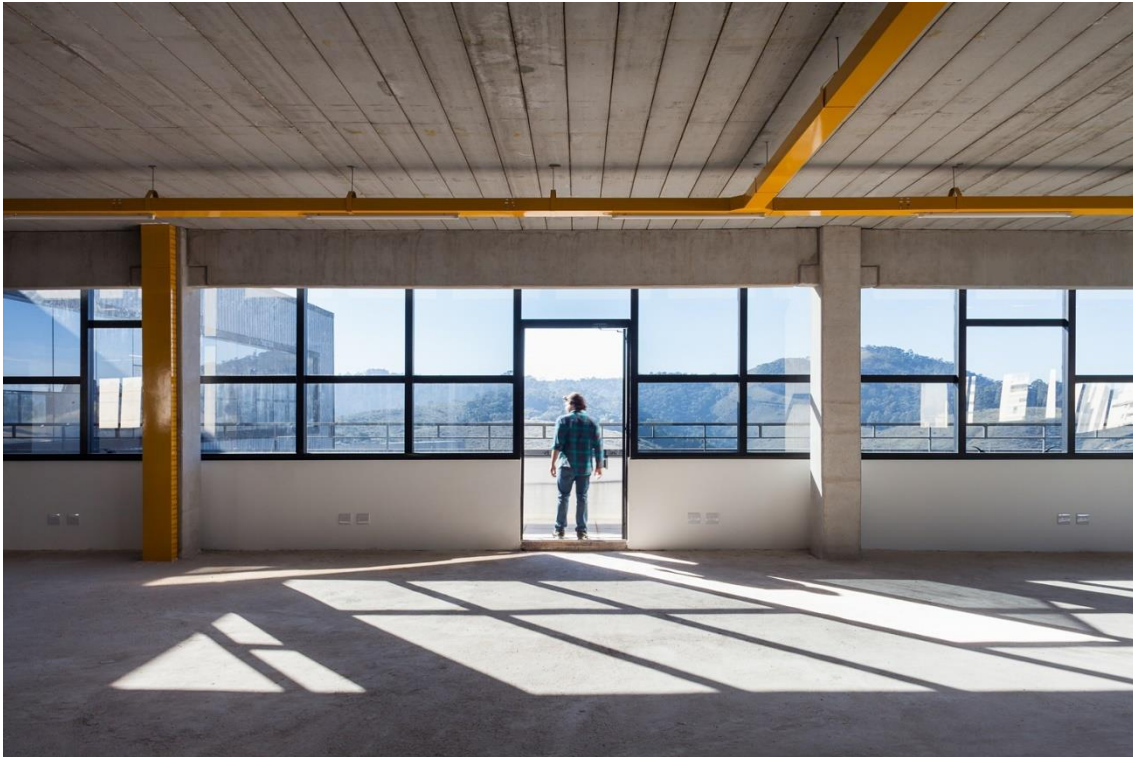
Figura 8 – Nova Quest: estrutura pré-moldada e eletrocalhas amarelas
