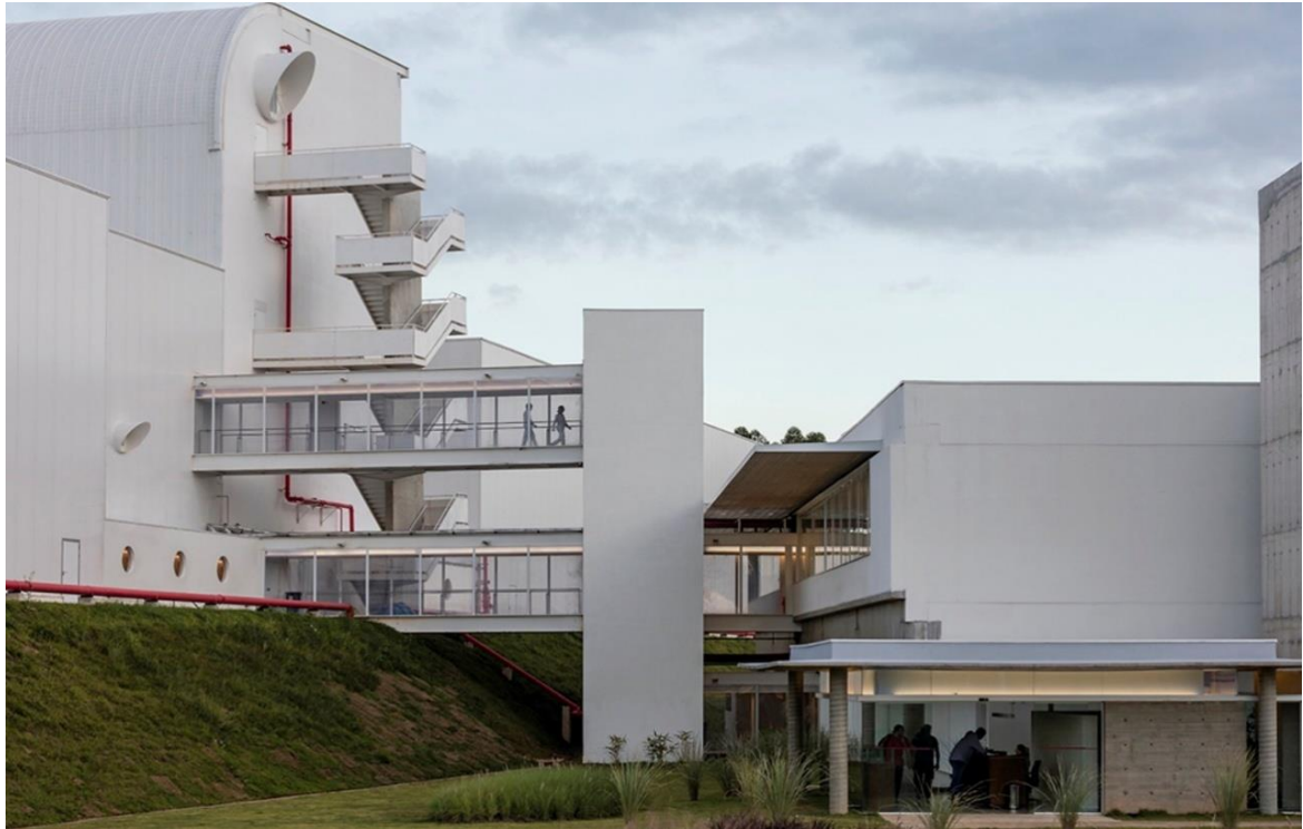
Figura 14 - Danone Early Life Nutrition: instalações especiais e exaustores telados
