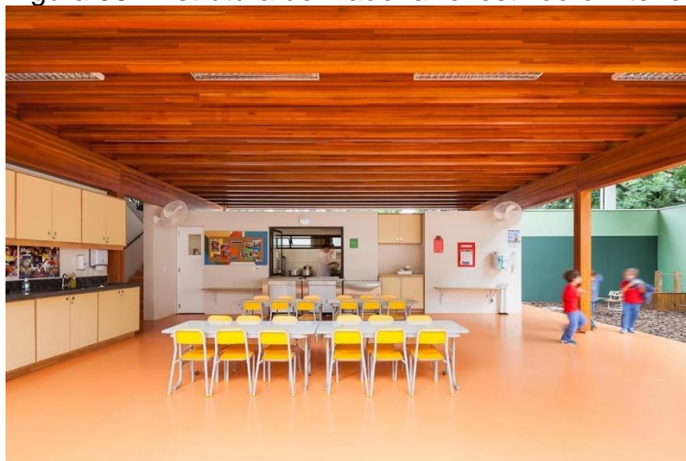
Figura 38 - Estrutura de madeira revestindo o interior
