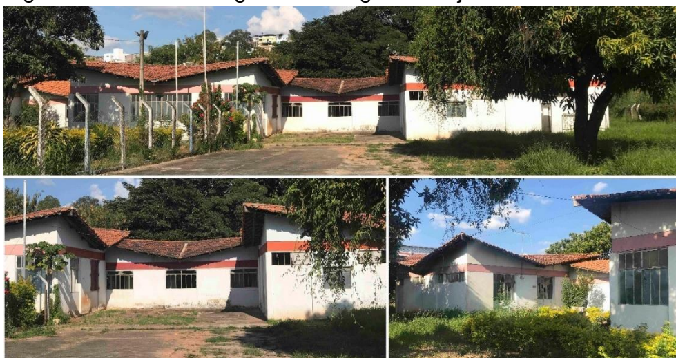
Figura 63 - Diversos ângulos da antiga edificação do CAPS
