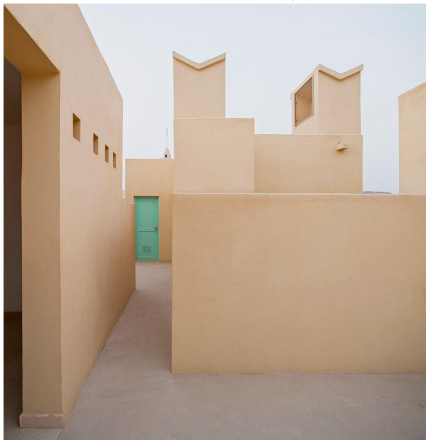
Figura 32 - Torres de ventilação natural
