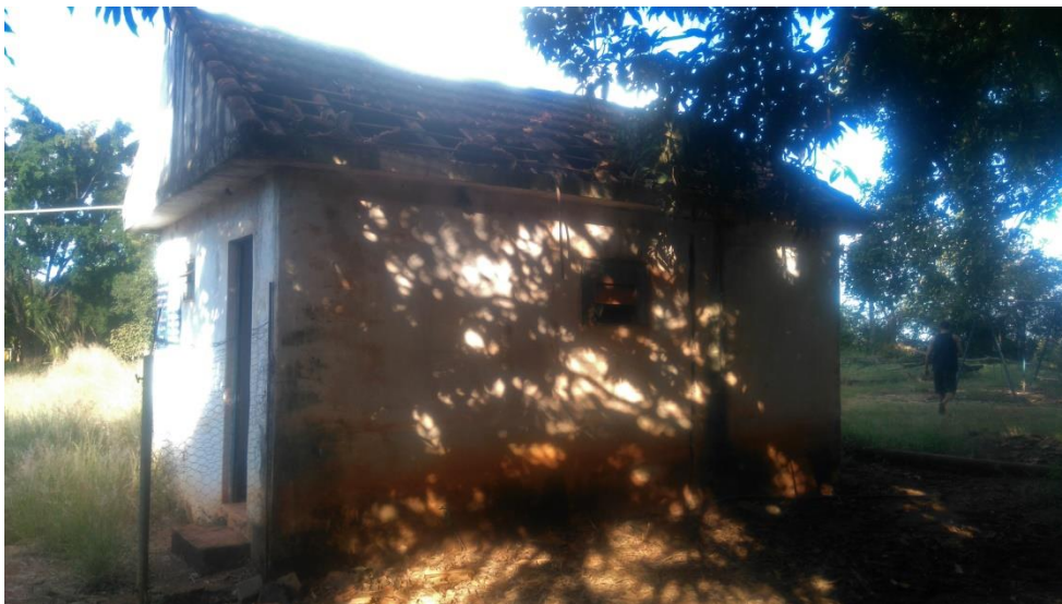
Figura 56 - Vestiário das piscinas
