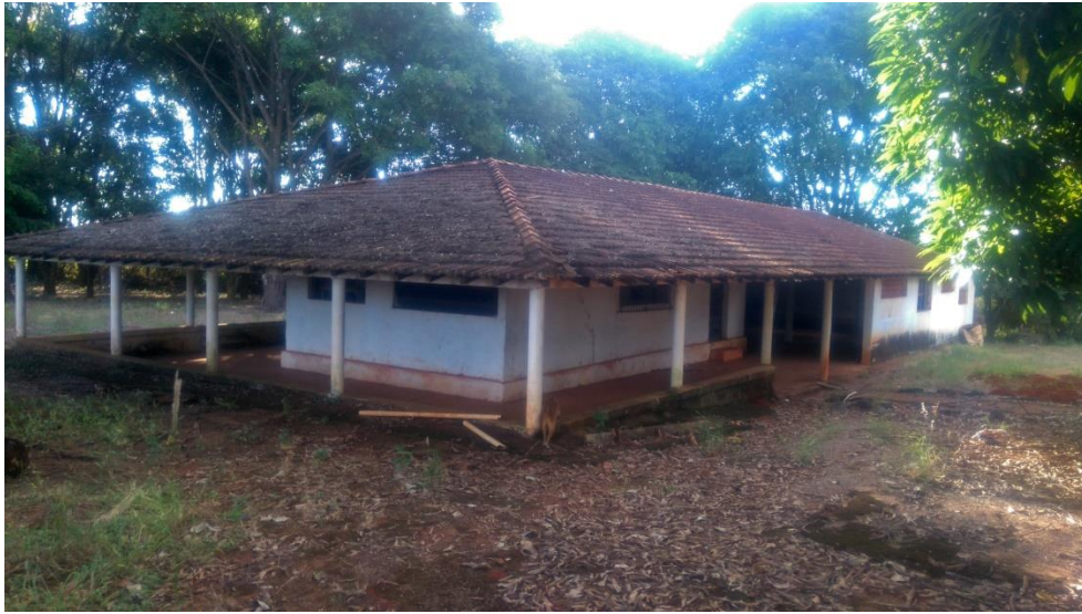
Figura 57 - Área de recreação coberta
