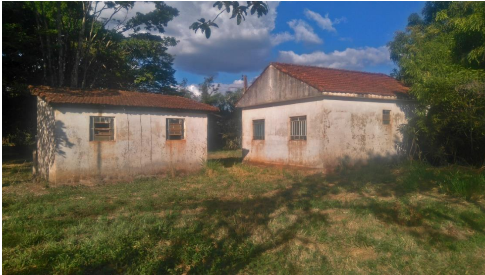
Figura 59 - Edificações de apoio
