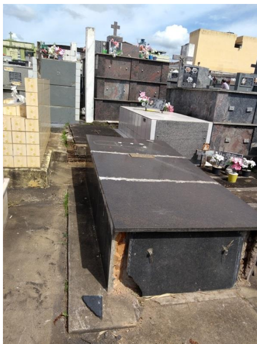
Figura 10 – Fechamento Mal feito Após a Colocação do Corpo no Túmulo
