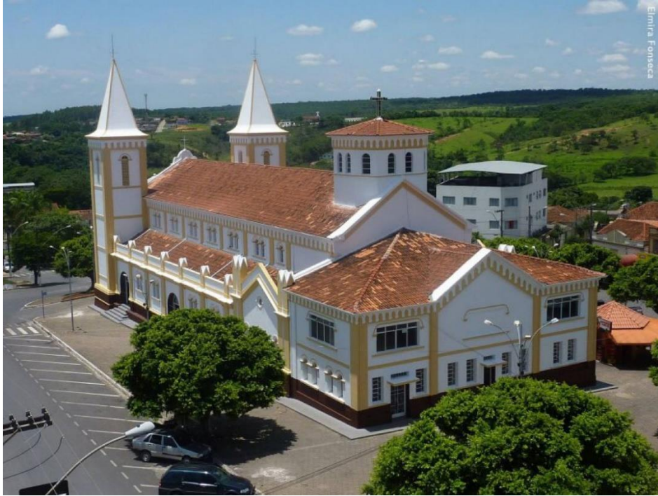
Figura 59 - Igreja matriz Nossa Senhora do Carmo
