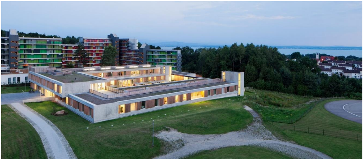
Figura 18 - Centro Psiquiátrico Friedrichshafen
