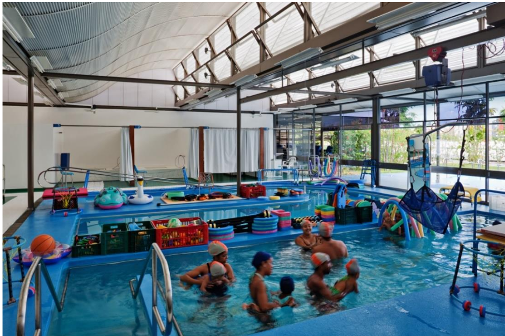
Figura 35 - Área de piscina com shed's metálicos e brises horizontais
