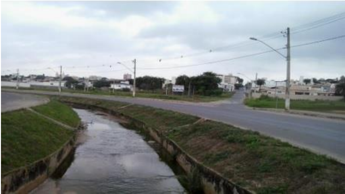
Figura 62 - Avenida Dr. João Vaz Sobrinho, trecho I
