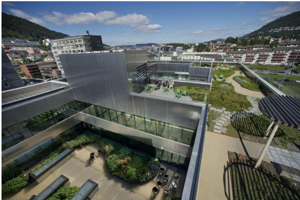
Figura 4 - Terraço jardim no Hospital Psiquiátrico Kronstad
