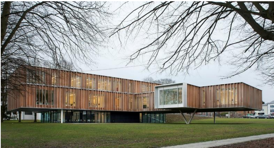
Figura 34 – Estrutura em balanço.
