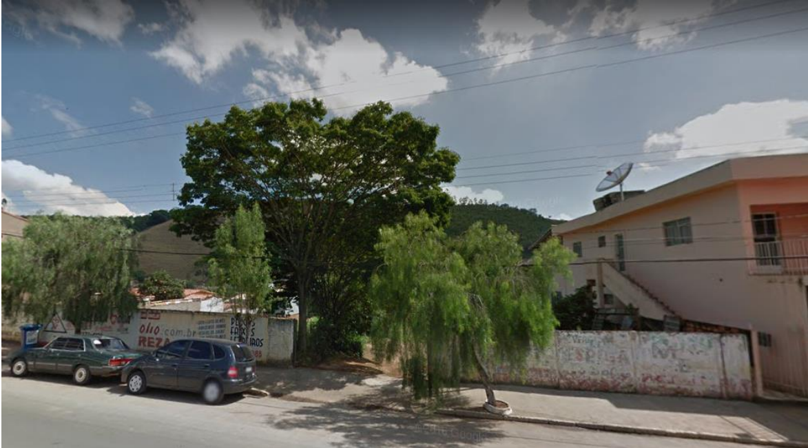
Figura 6 – Fachada frontal da área do projeto (portão aberto)
