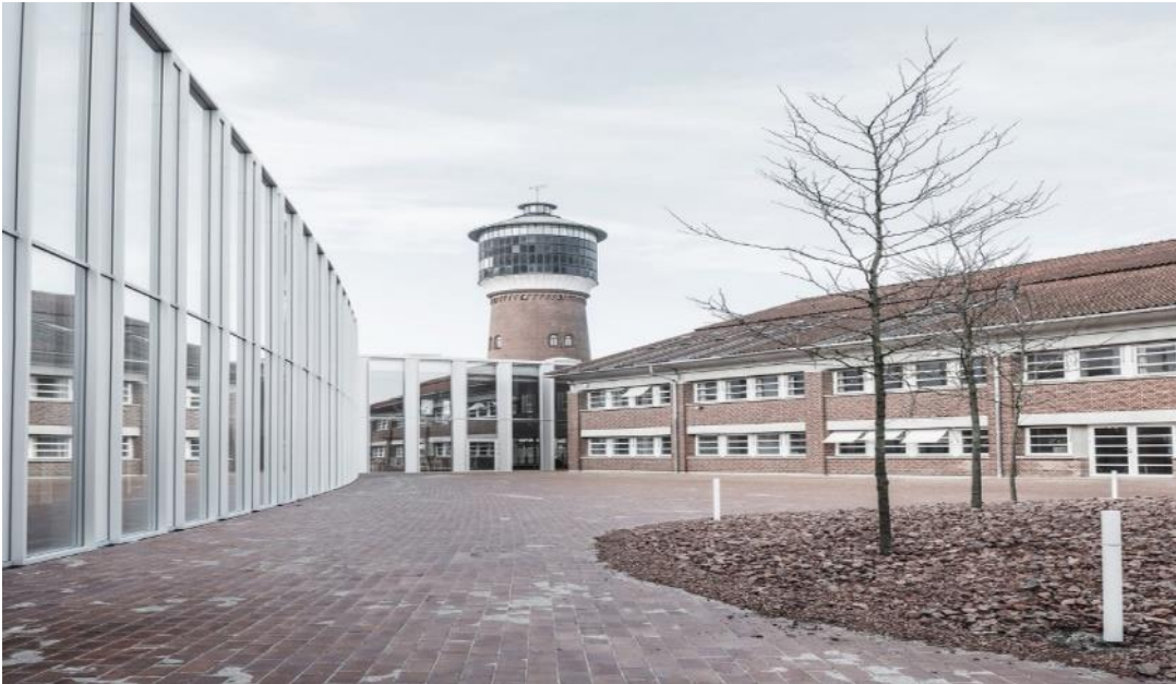
Figura 29 – Justaposição do antigo e novo edifício da Prefeitura.
