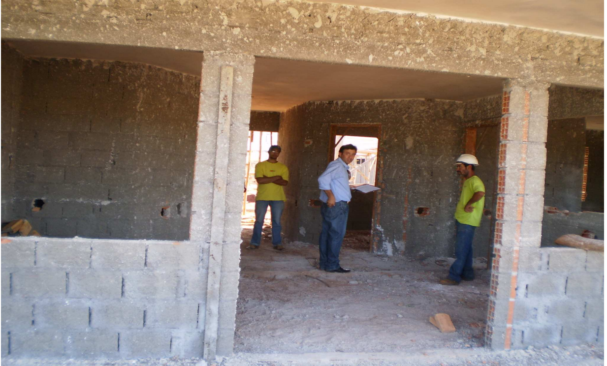
FIGURA 12 - Obra sendo fiscalizada por funcionários da instituição
