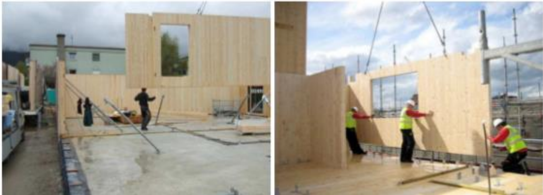
Figura 3 – Uso de painéis de CLT
