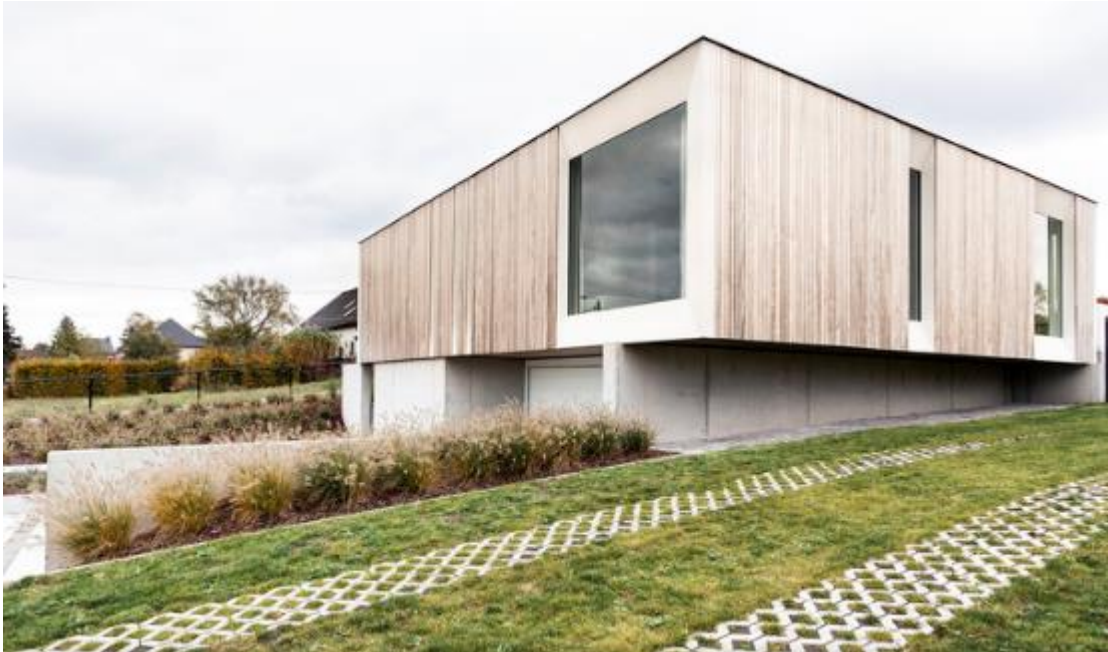
Figura 4 – Edificações utilizando painéis de CLT
