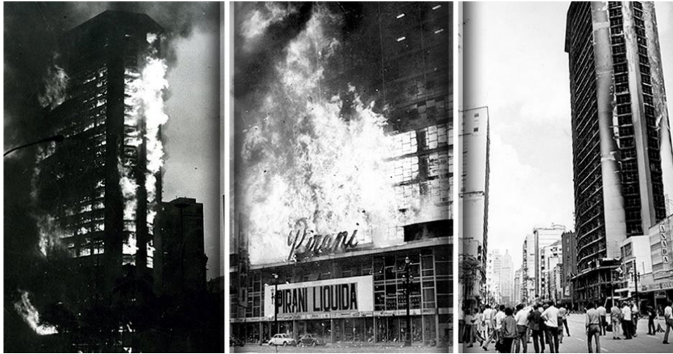
FIGURA 18 – Incêndio ocorrido no Andraus-São Paulo, 1972.
