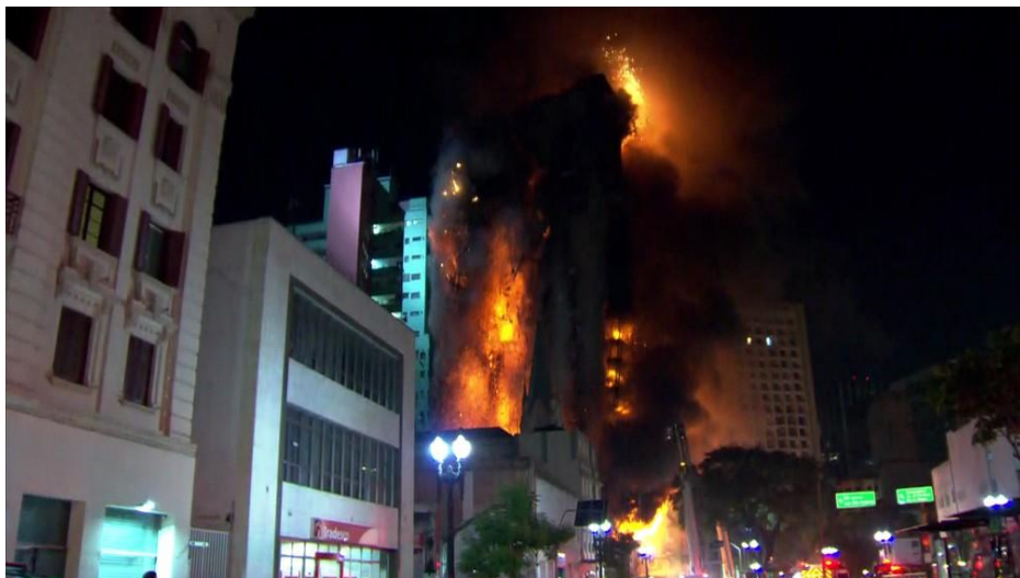
FIGURA 21-Início do desabamento do edifício.
