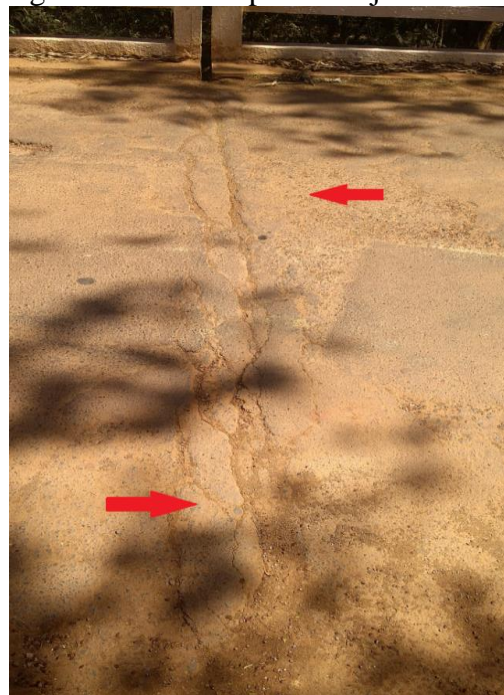
Figura 34- Vista superior da junta de dilatação
