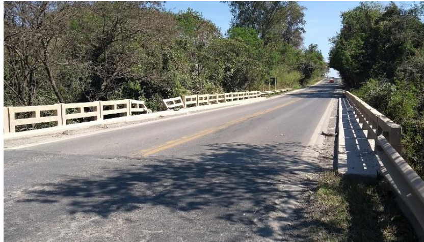
Figura 18- Vista superior da ponte 1
