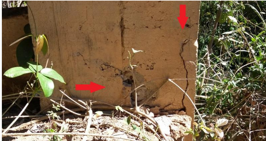
Figura 27- Vista frontal do pilar
