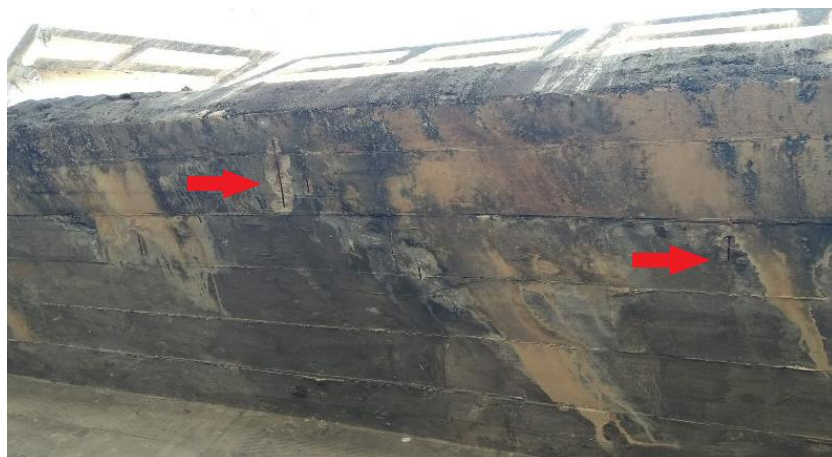
Figura 28 - Armaduras expostas
