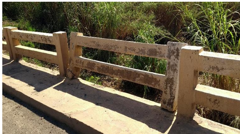
Figura 30 - Guarda-corpo danificado
