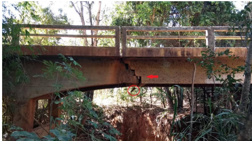
Figura 35 - Vista lateral da junta de dilatação
