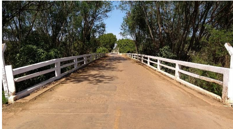
Figura 20 - Vista superior da ponte 3
