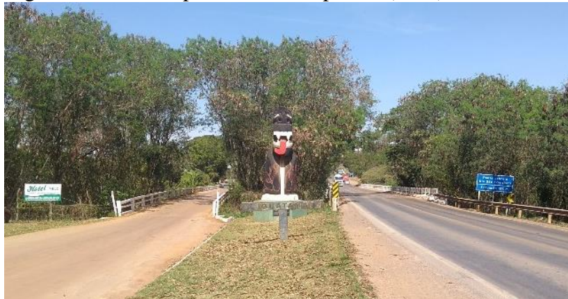
Figura 22 - Vista superior das duas pontes (3 e 4)
