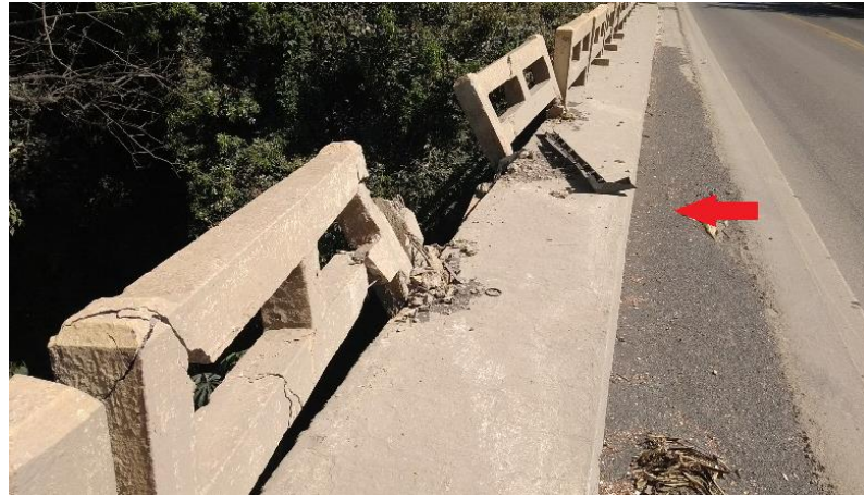
Figura 25 - Guarda-corpo destruído
