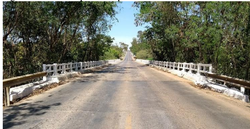
Figura 23 - Vista superior da ponte 4
