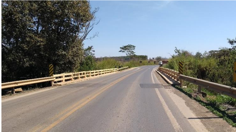
Figura 19 - Vista superior da ponte 2
