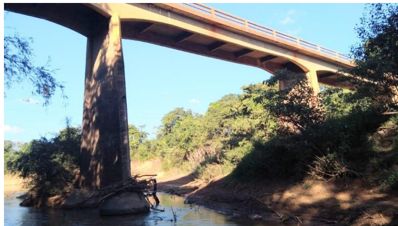
Figura 21 - Vista lateral da ponte 3
