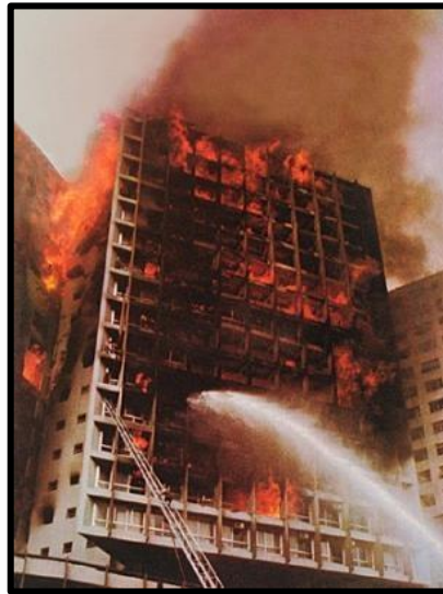
Figura 2 - Edifício Joelma em chamas.
