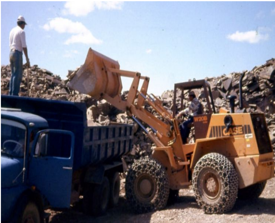
FIGURA 7 – Foto do transporte do material. FONTE: Pereira, 2009.
