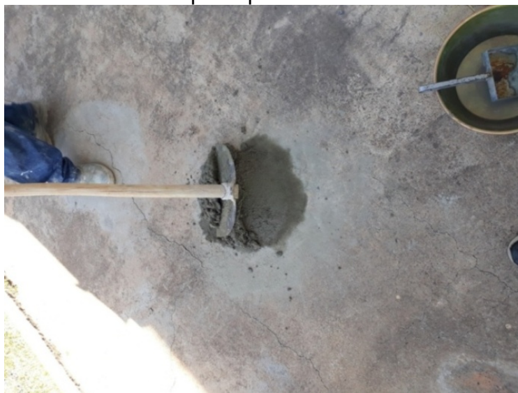
Figura 9 – Mistura manual do material para confecção dos corpe-de-prova
