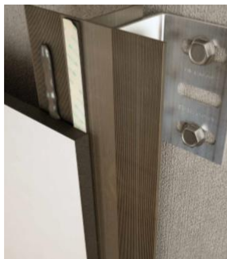
Figura 16 - Dispositivo de fixação adesivo estrutural
