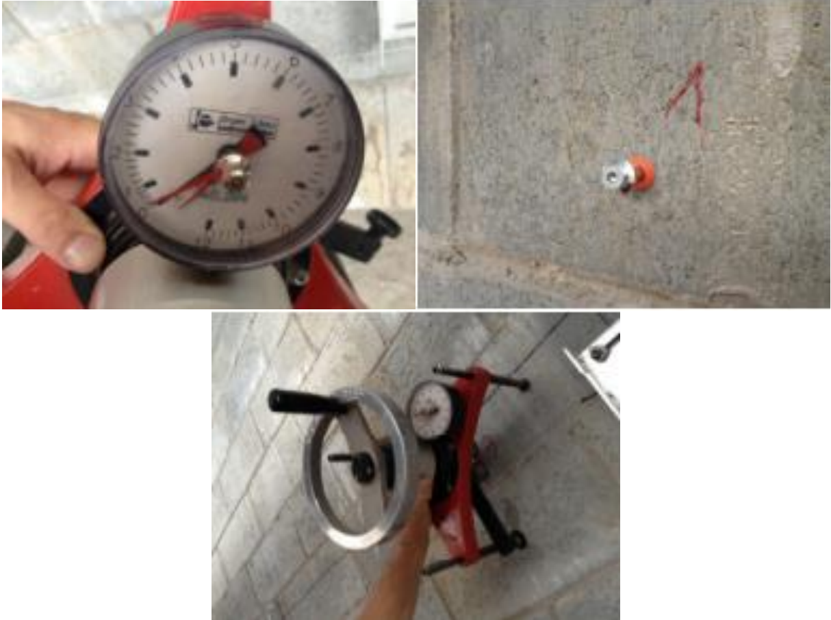
Figura 37 - Teste de arrancamento
