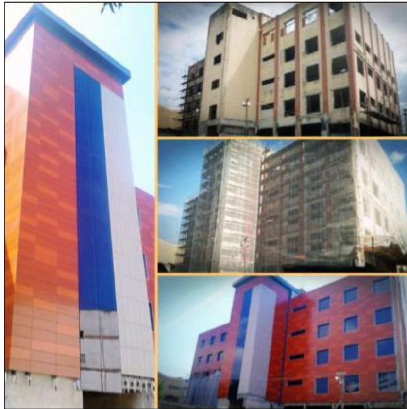
Figura 23 - Retrofit utilizando o sistema de fachada ventilada
