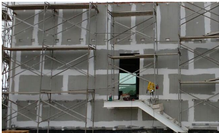
Figura 30 - Fixação cantoneiras elevação substrato drywall
