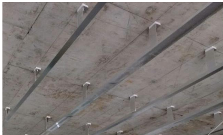
Figura 33 - Cantoneiras fixadas na laje protendida
