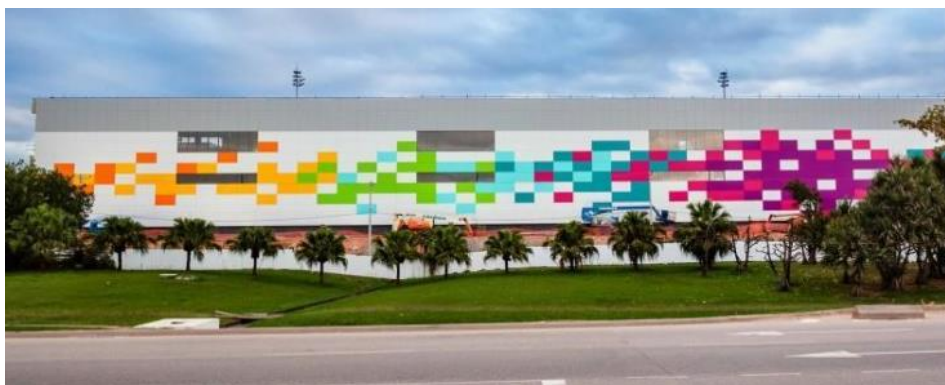
Figura 9 - Fachada ventilada em ACM
