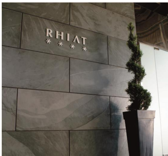
Figura 4 - Fachada ventilada em pedra natural
