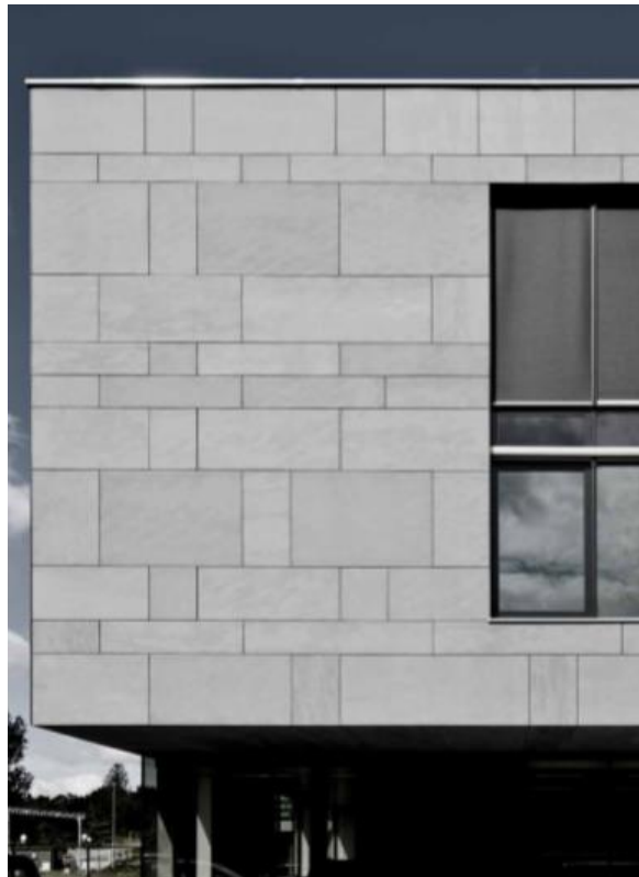
Figura 6 - Fachada de fibrocimento
