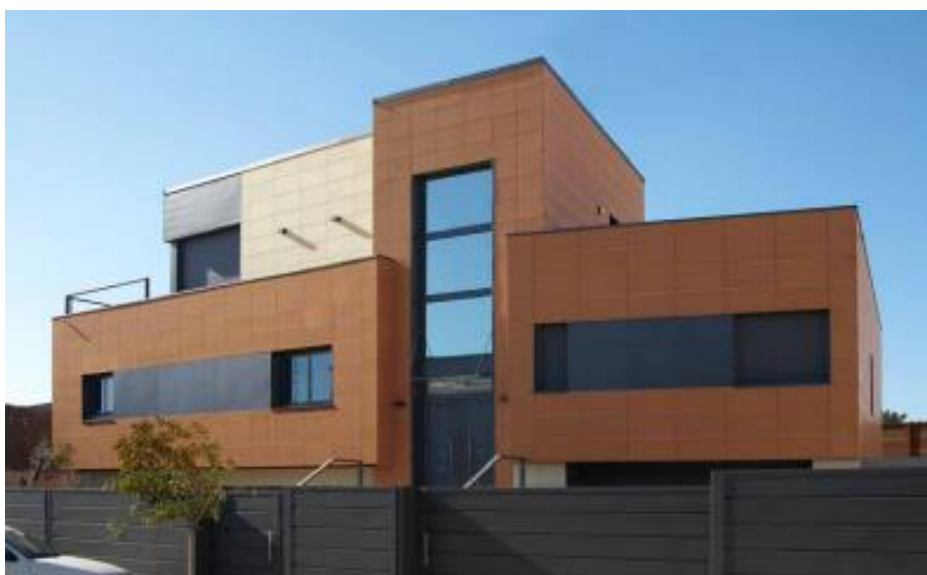
Figura 5 - Fachada em cerâmica extrudada
