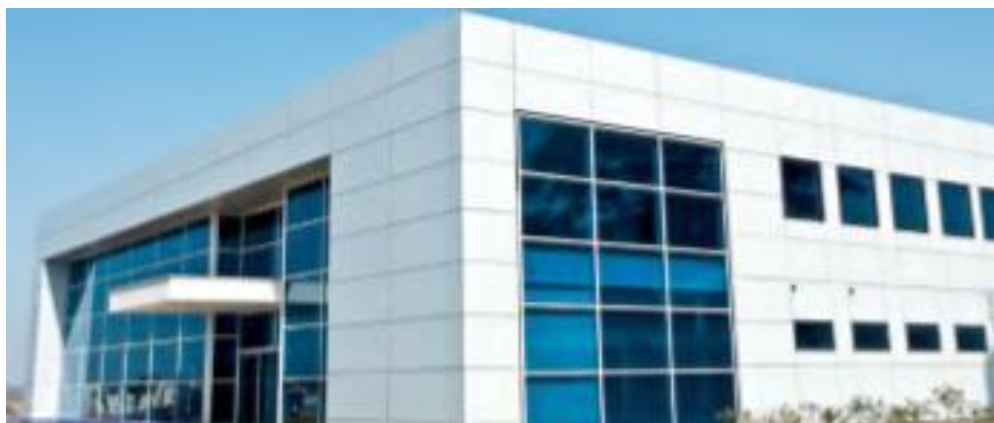
Figura 3 - Fachada ventilada em porcelanato
