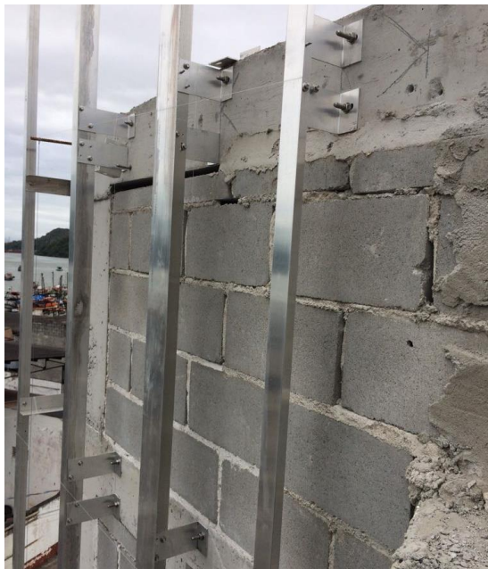
Figura 27 - Fixação dos montantes verticais
