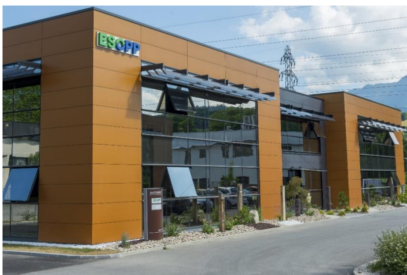
Figura 8 - Fachada ventilada em painel fenólico
