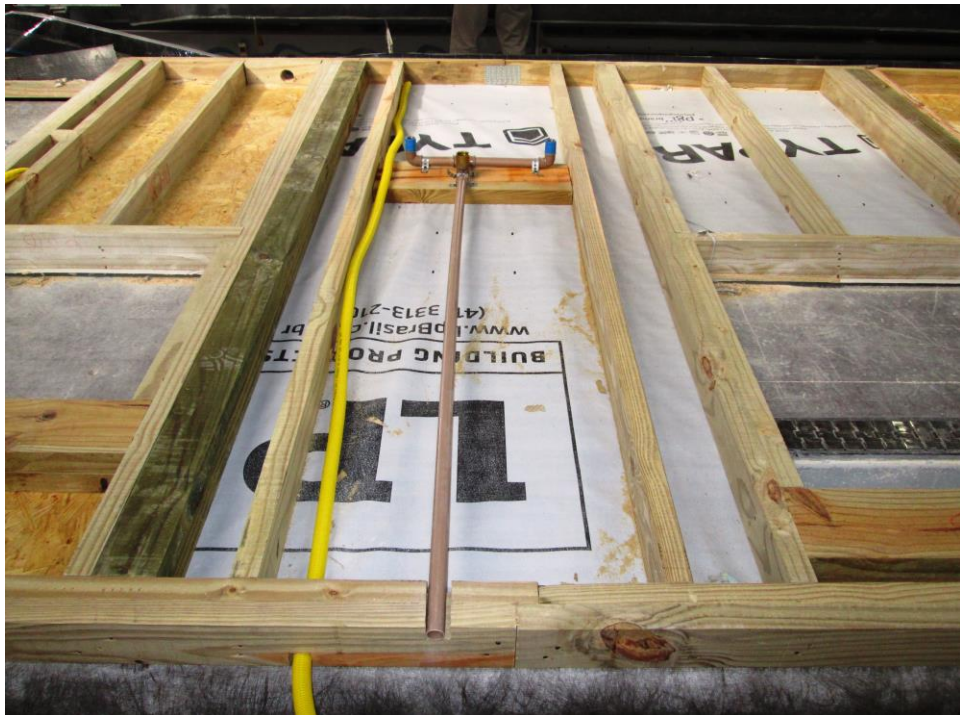
Figura 16 - Instalações elétrica e hidráulica no wood frame
