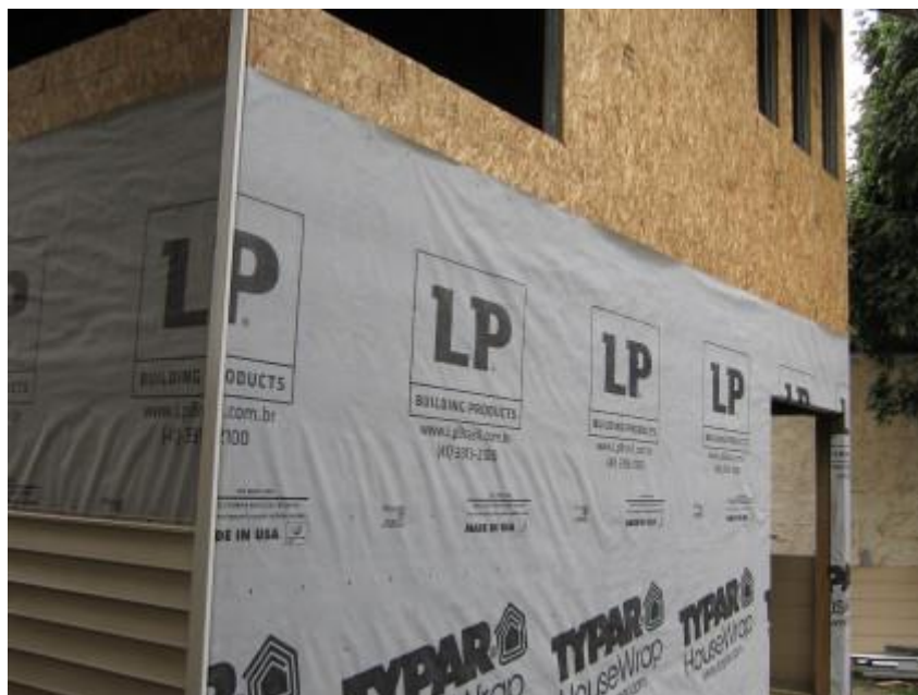
Figura 10 - Membrana hidrófuga sobre o OSB
