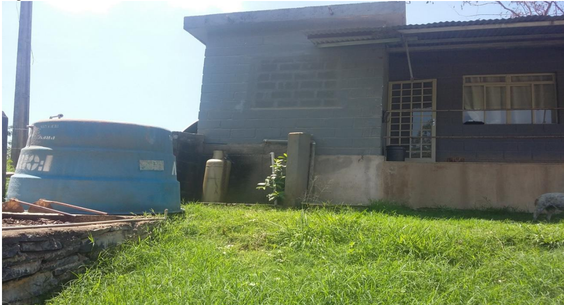
Figura 11 - Central de GLP
