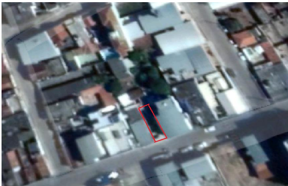
Figura 11 – Localização da obra estudada
