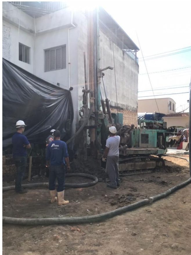
Figura 17 – Estaca de hélice contínua na obra
