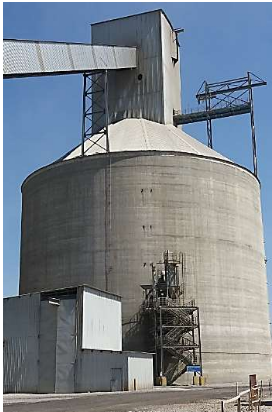
Figura 9 - Silo de Estocagem de Clínquer
