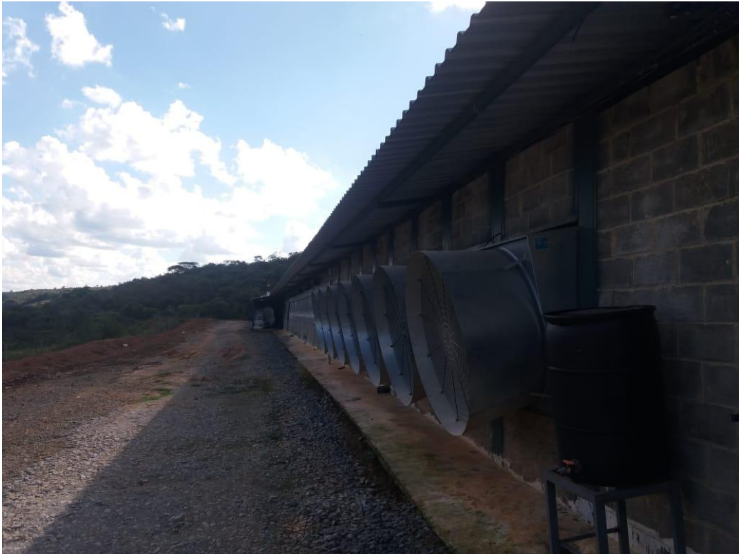
Figura 3 - Granja, da fazenda Boa Esperança, de pressão negativa onde foram coletados os dados para o experimento
