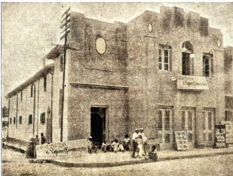
Figura 10 – Vista frontal do Teatro Municipal de Formiga/MG
