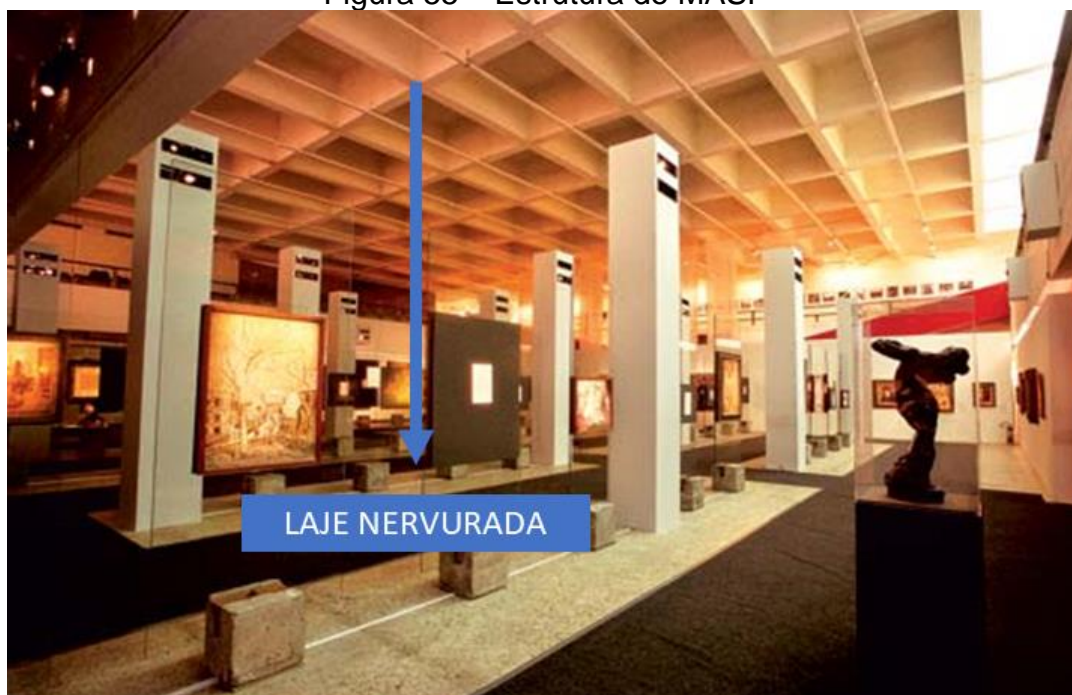
Figura 55 – Estrutura do MASP
