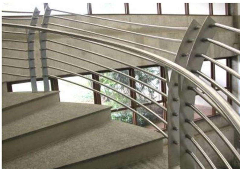
Figura 1 - Corrimão e guarda-corpo
