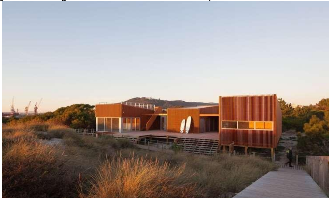
Figura 7 - Vista geral do Centro de Atividades Esportivas
