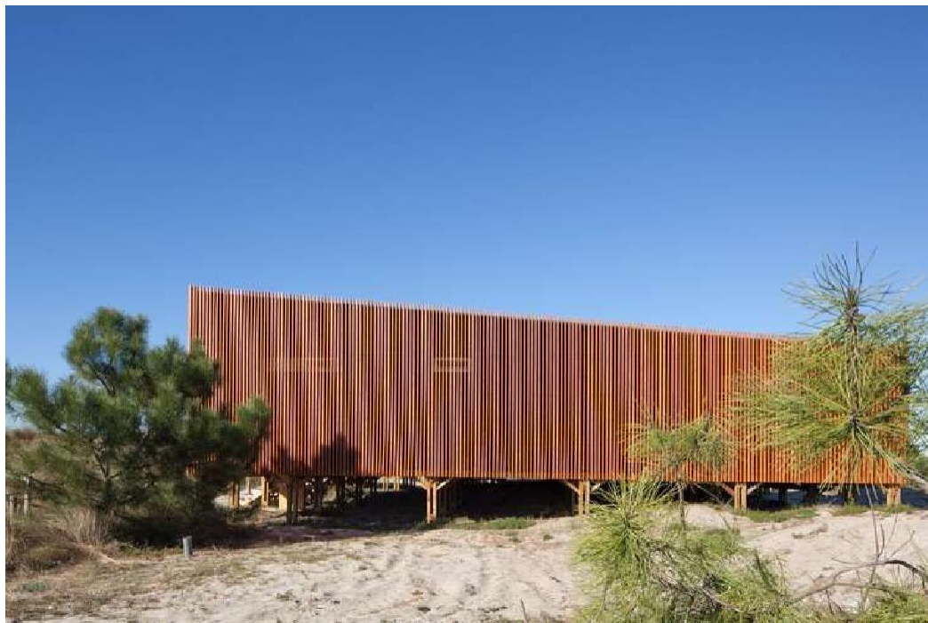
Figura 11 - Estrutura de madeira
