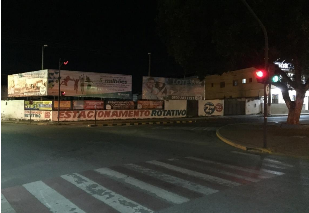
Figura 20 – Vista do terreno com a Praça Ferreira Pires.
