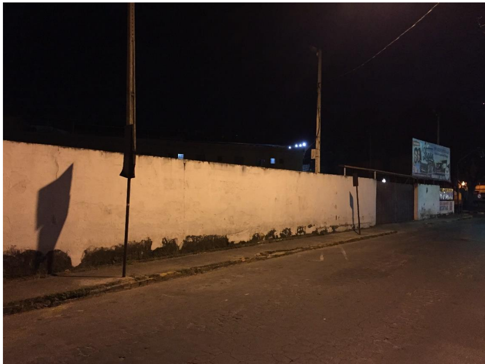
Figura 21 – Vista principal do terreno com acesso pela rua General Carneiro
