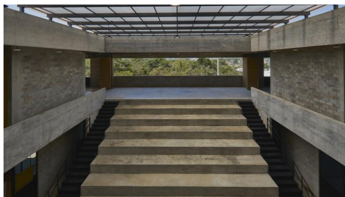
Figura 54 - Vista interna da edificação
