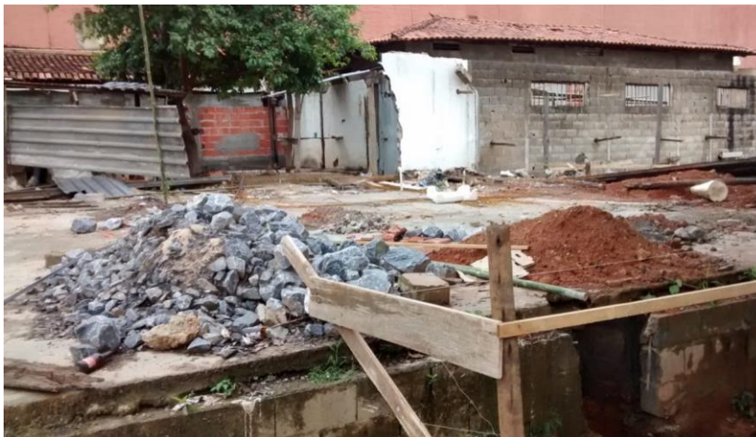
Figura 78 - Vista do terreno da Rua Jacinto da Veiga
