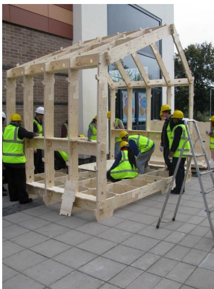
Figura 44 – Montagem de uma Wikihouse
