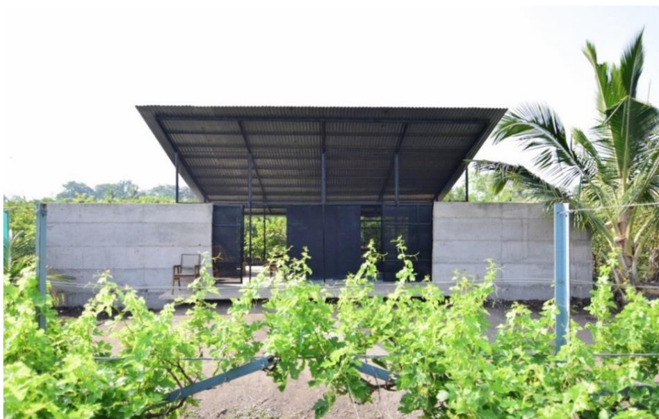
Figura 34 – Tipologia de varanda do pavilhão
