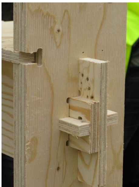
Figura 42 – Sistema de encaixe de uma Wikihouse
