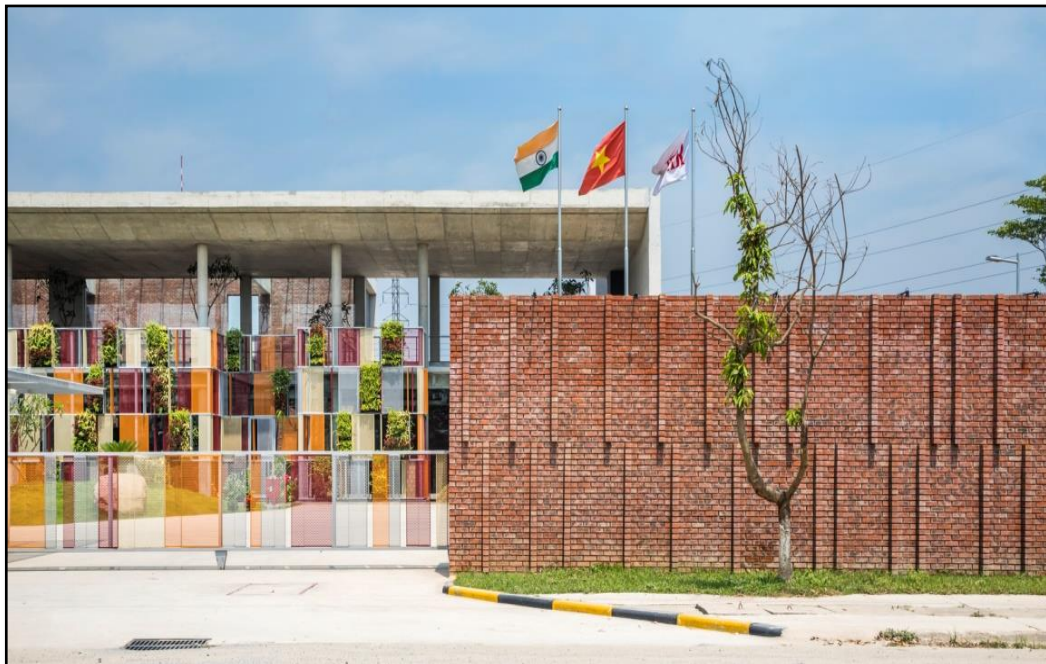
Figura 38 - Fachada frontal da Fábrica de Star Engineers
