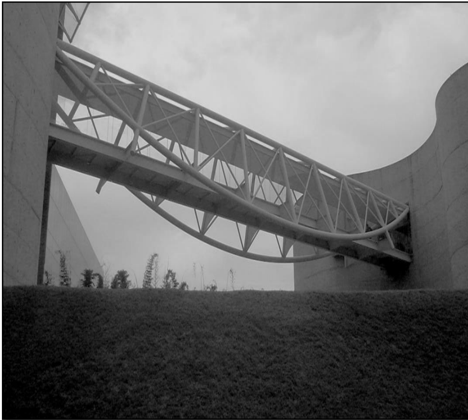
Figura 57 - Vista da passarela de circulação horizontal
