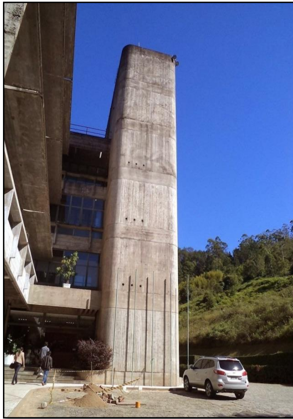
Figura 34 - Torre de circulação vertical
