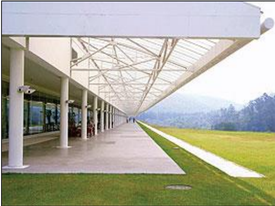
Figura 61 - Varanda em estrutura metálica e telha de policarbonato
