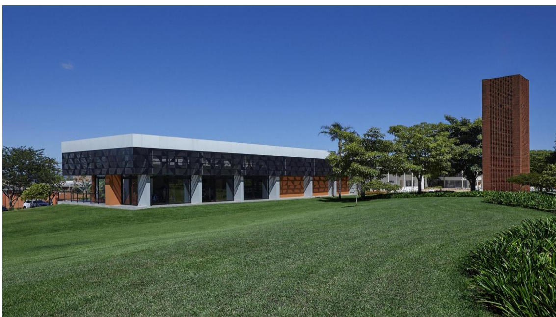
Figura 73 – Fachadas protegidas por placas de alumínio composto.
