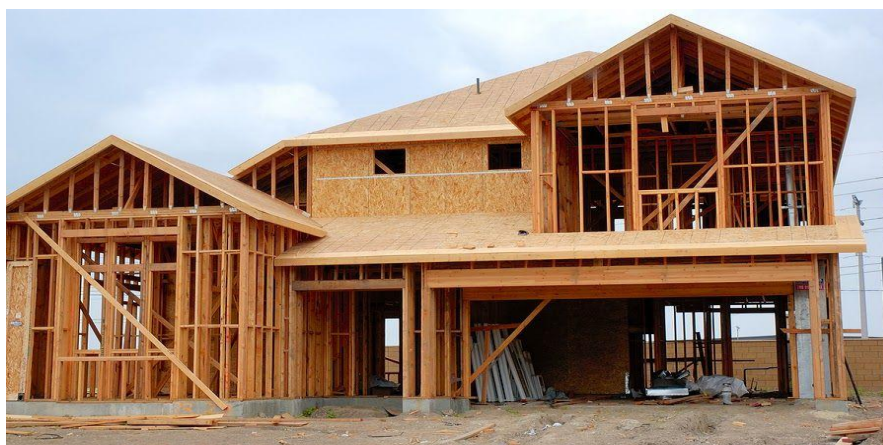
Figura 8 – Estrutura de residência em Wood Frame
