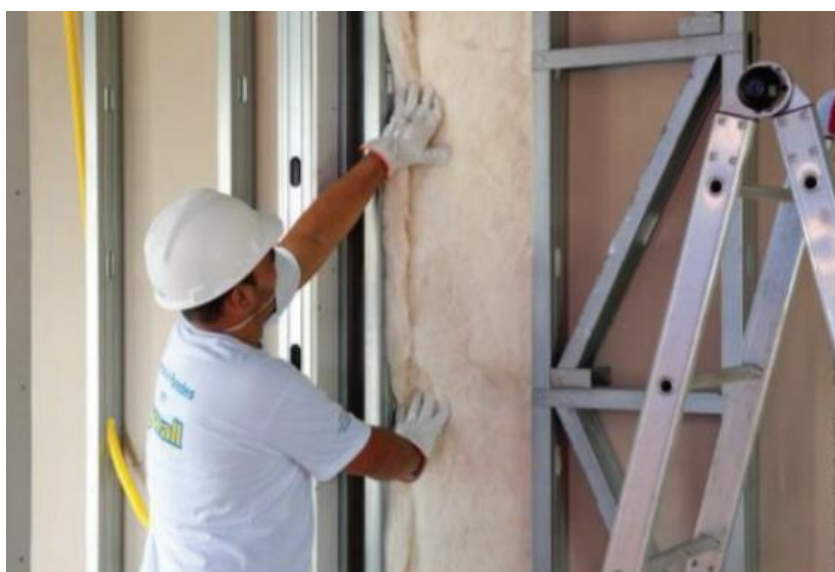
Figura 21 – Detalhe de isolamento de vedações em LSF
