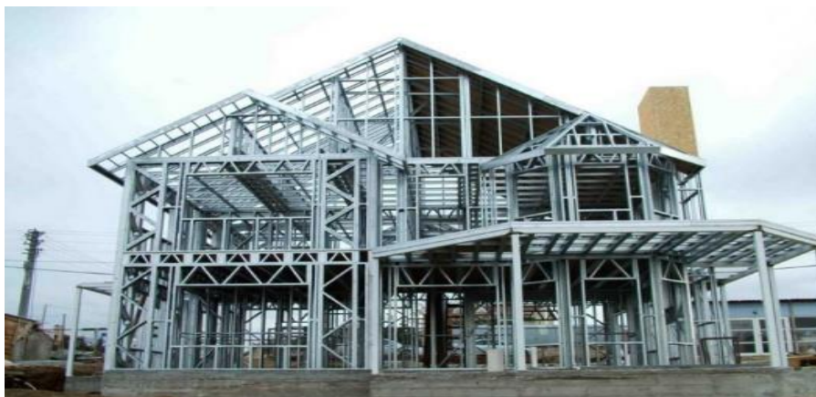
Figura 7 – Estrutura de residência Light Steel Framing
