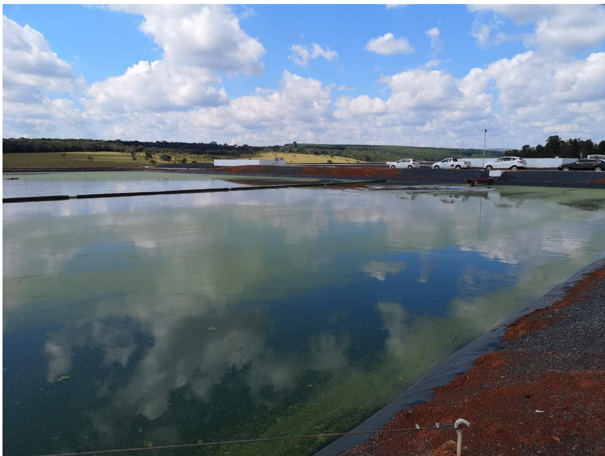
Figura 38 - Estação de tratamento de esgoto
