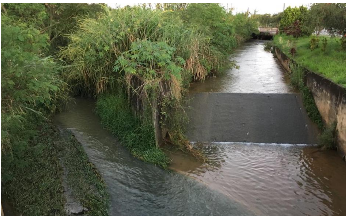
Figura 04 - Situação atual do rio dos arcos
