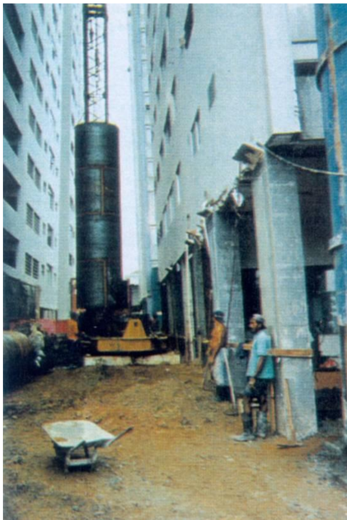
Figura 30: Escavação de estacas com encamisamento metálico.
