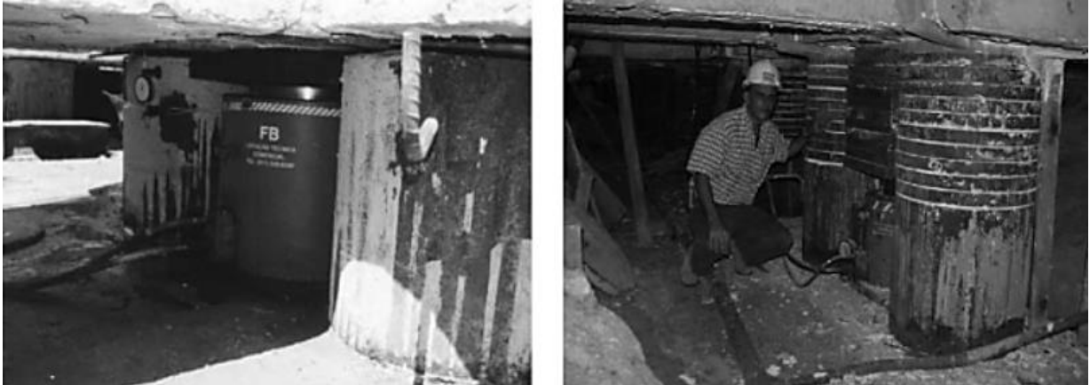
Figura 33: Edifício suspenso por macacos hidráulicos.
