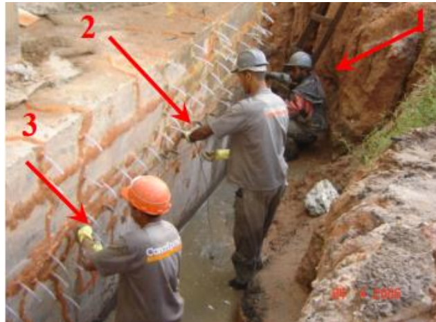
Figura 43: Processo de injeção do microcimento.
