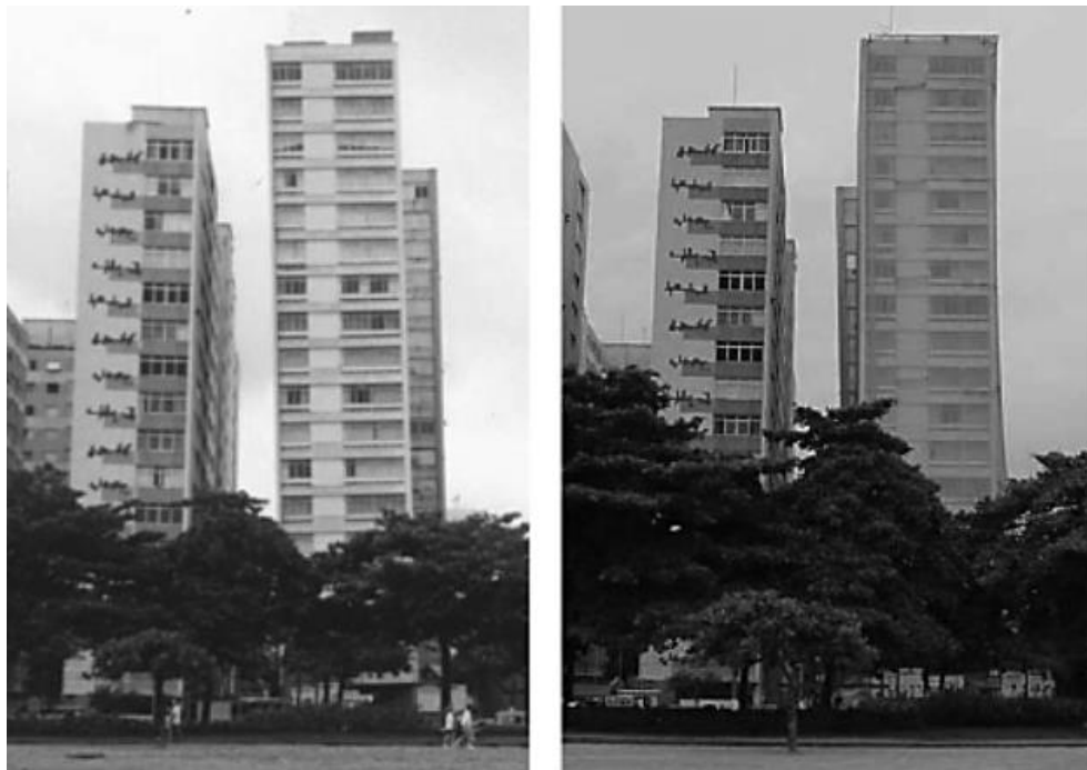
Figura 35: Edifício Núncio Malzoni antes e depois do reaprumo.
