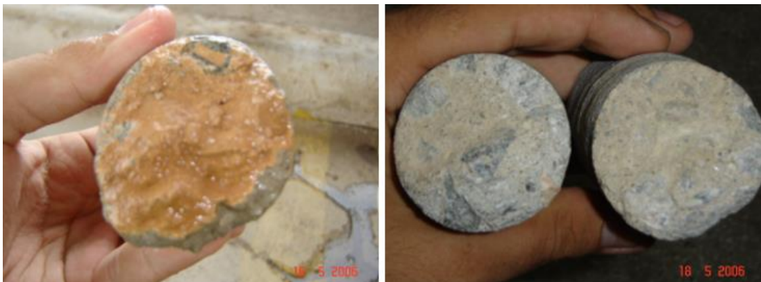
Figura 42: Antes e depois da lavagem interna das trincas.
