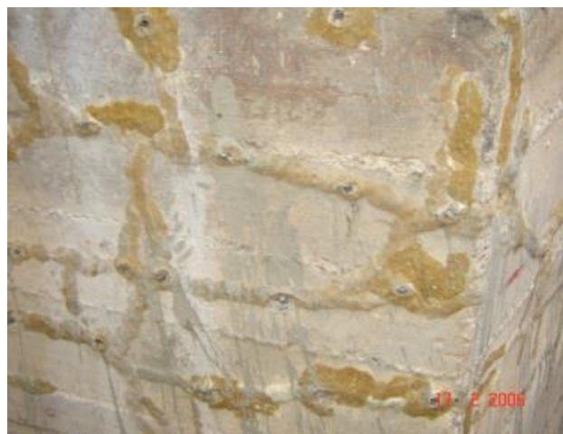
Figura 44: Bloco após recuperação
