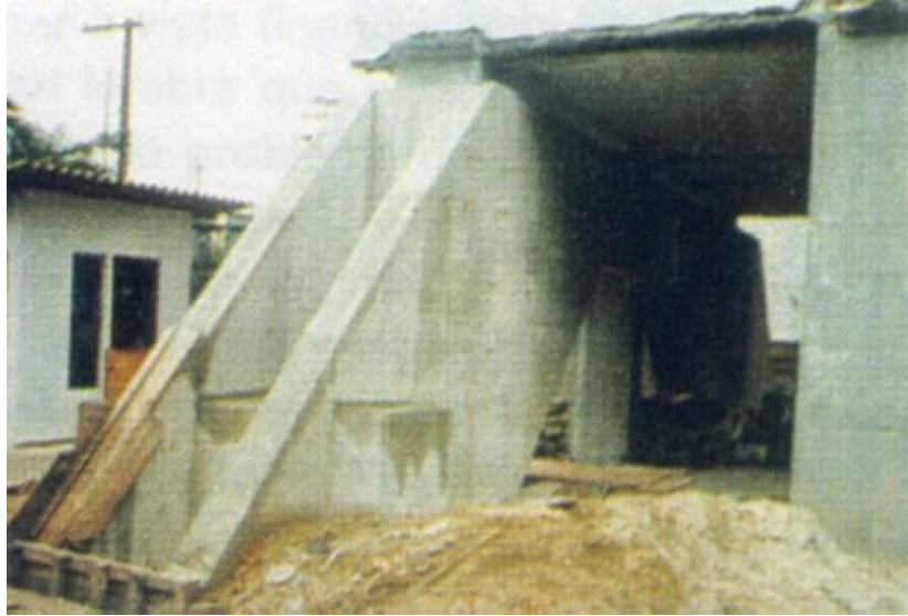
Figura 31: Construção de vigas de transição.
