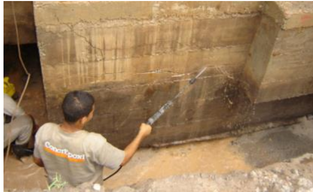
Figura 39: Lavagem da face dos blocos
