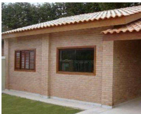
Figura 14 - Alvenaria de tijolo de solo-cimento com acabamento aparente
