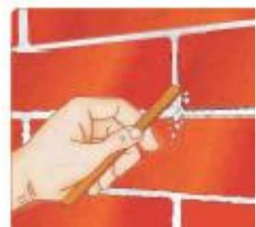
Figura 51 - Execução do acabamento sob o rejunte
