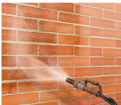
Figura 49 - Aplicação de impermeabilizante incolor
