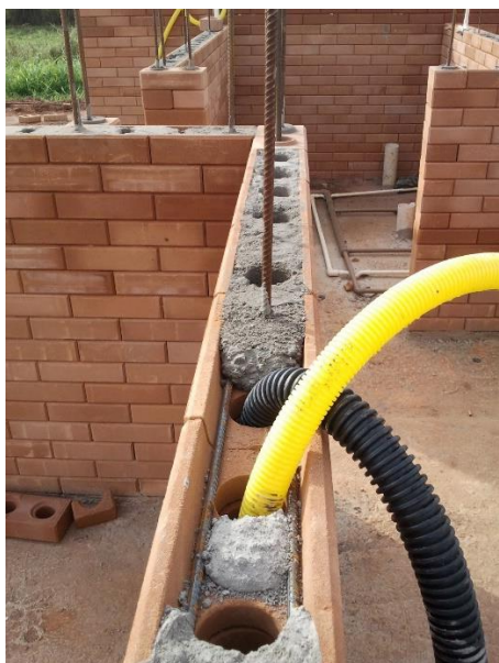
Figura 15 - Execução de vigas, pilares e passagem de tubulações hidráulicas e elétricas em tijolos de solo-cimento.
