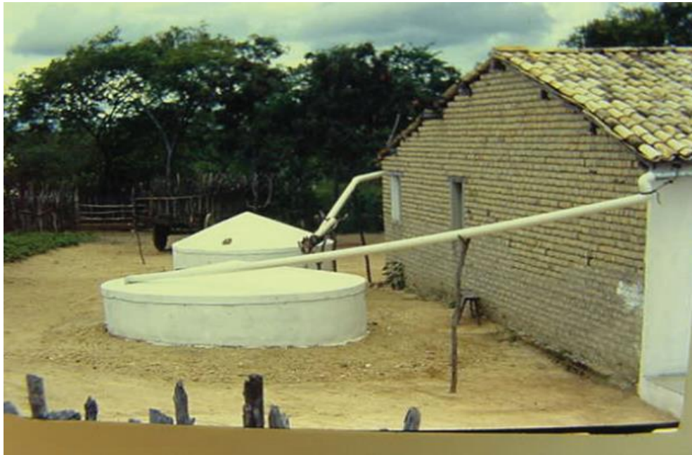
Figura 2 - Cisternas de placa e sistema de coleta de água do telhado.
