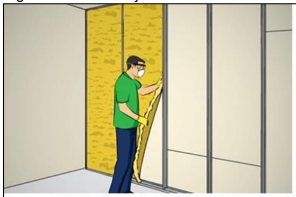
Figura 20 - Colocação de isolamento
