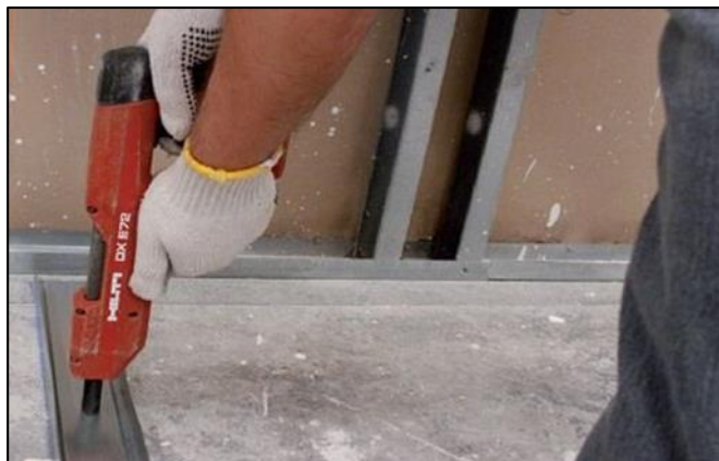
Figura 18 - Fixação das guias
