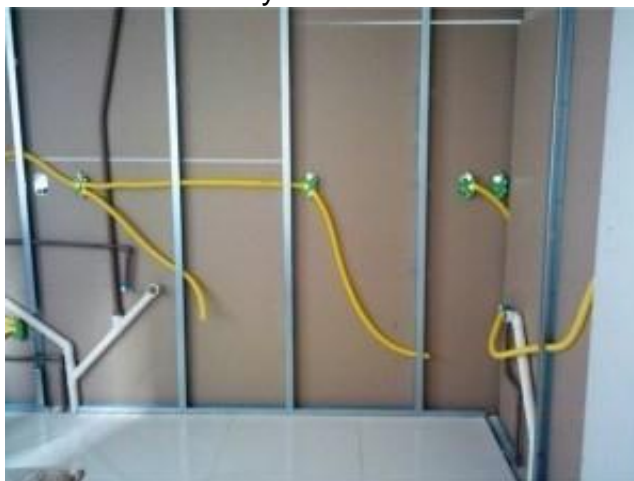
Figura 10 – Execução de instalações elétricas em Drywall
