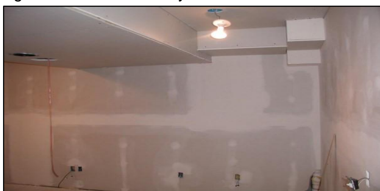
Figura 23 - Placas de Drywall instaladas
