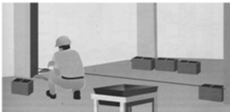
Figura 29 – Marcação da Alvenaria
