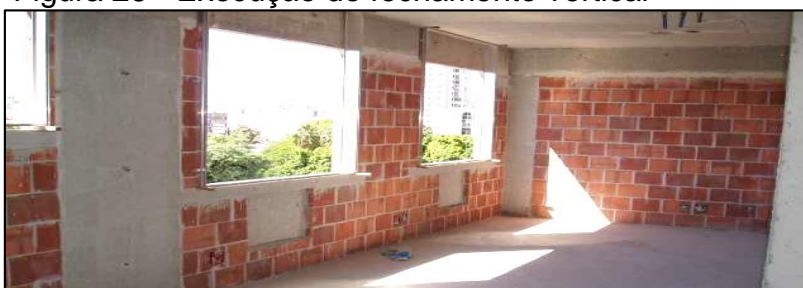
Figura 26 - Execução de fechamento vertical
