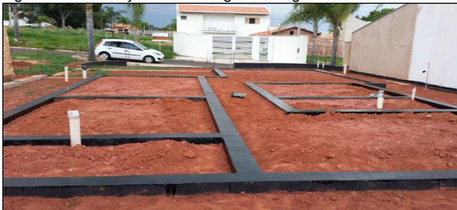
Figura 25 - Fundação: Concretagem de vigas baldrames
