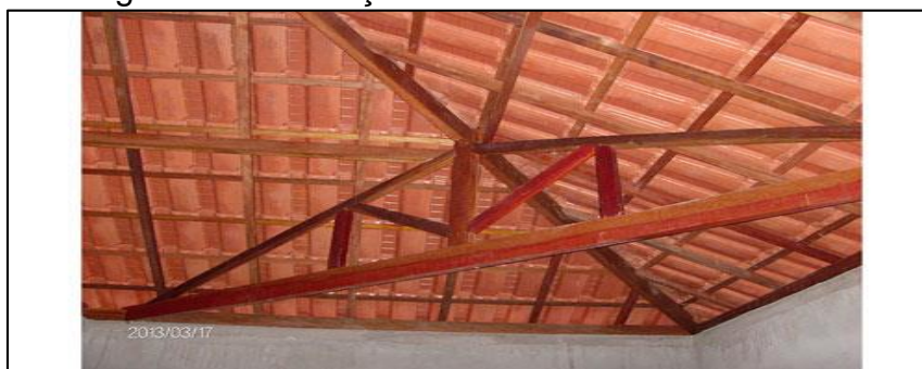
Figura 31 - Execução de cobertura
