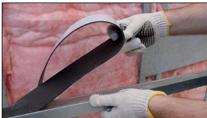
Figura 17 - Instalação das fitas de isolamento
