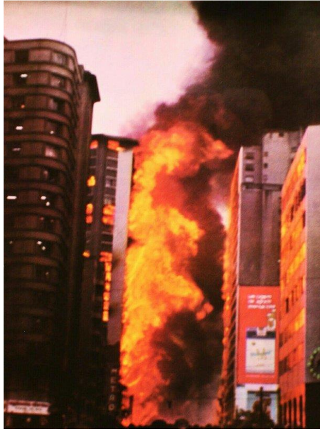
Figura 1 – Edifício Andraus em chamas.
