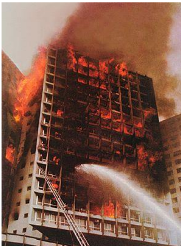
Figura 2 – Edifício Joelma em chamas.
