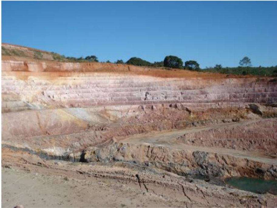
FIGURA 14 – Talude SE da mina, mostrando rupturas nos bancos inferiores, pela saturação por água subterrânea nesta área Fonte: Arquivo da empresa
