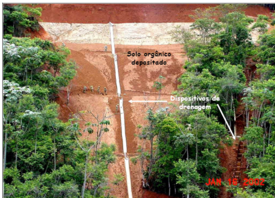
FIGURA 3 – Área degradada da mina Piçarrão após reconformação topográfica e implantação de sistemas de drenagem Fonte: Jordy Filho, 2008
