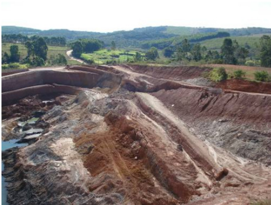
FIGURA 15 – Ruptura nos taludes do lado N da mina Fonte: Arquivo da empresa
