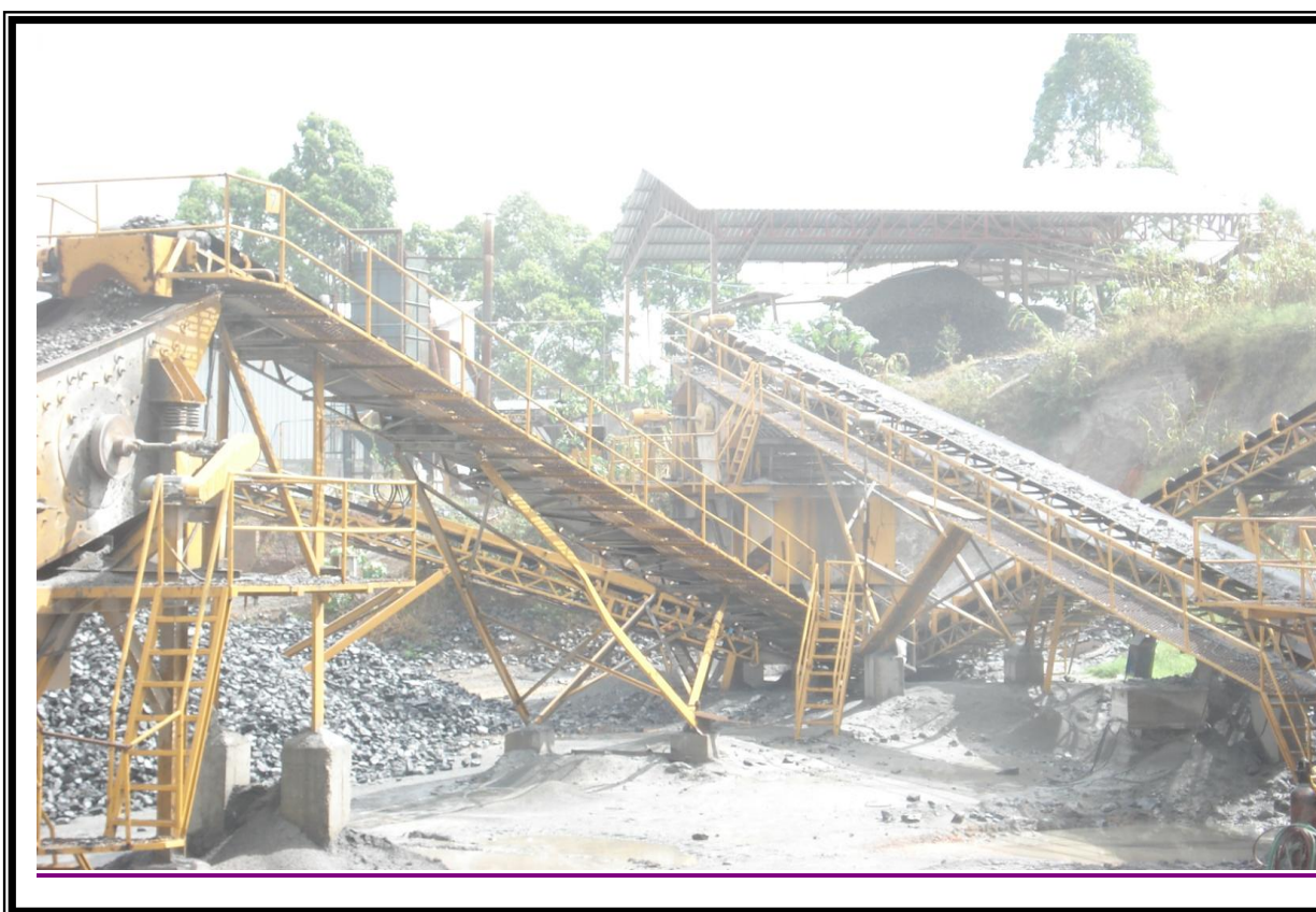
Figura 2 – Setor de Britagem da Gecal
